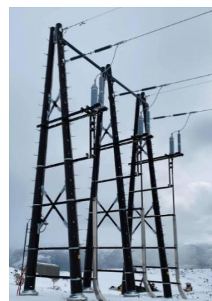
Figur 2 viser det alternative mastedesignet som Elvia har vurdert, hvor linjene er lagt i horisontalt planoppheng
