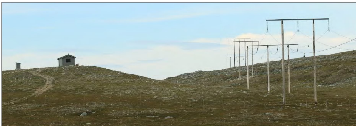
Figur 5-8. Hytte på fjellet vest for Børselva (eid av Statnett). Denne hytta ligger ca. 50 m fra dagens 300 kV ledning. Ny 420 kV ledning vil ligge på motsatt side, og avstanden vil da bli i overkant av 100 m.
