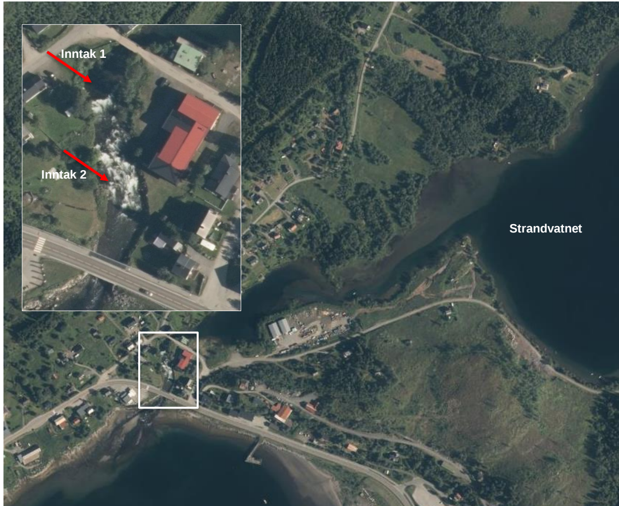
Figur 1 Oversiktsbilde med avmerking av planlagte inntakspunkter (røde piler) for vannforsyning til RAS-anlegg.
