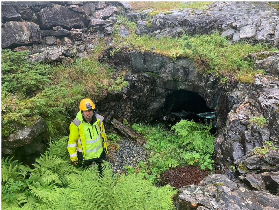
Bilde 6: Tunnelmunningen til den gamle tunnelen nedstrøms dammen.
