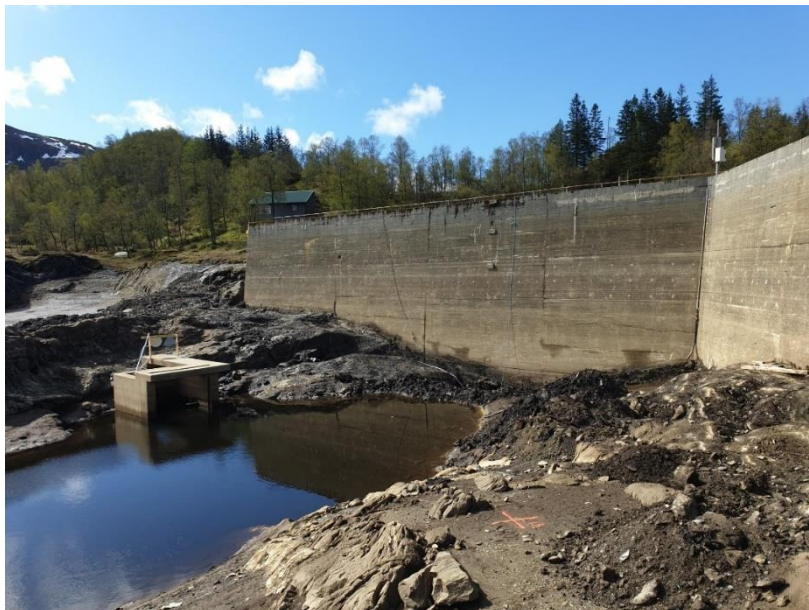
Bilde 2: Bildet viser både inntakskonstruksjon og dammens dypeste del.
