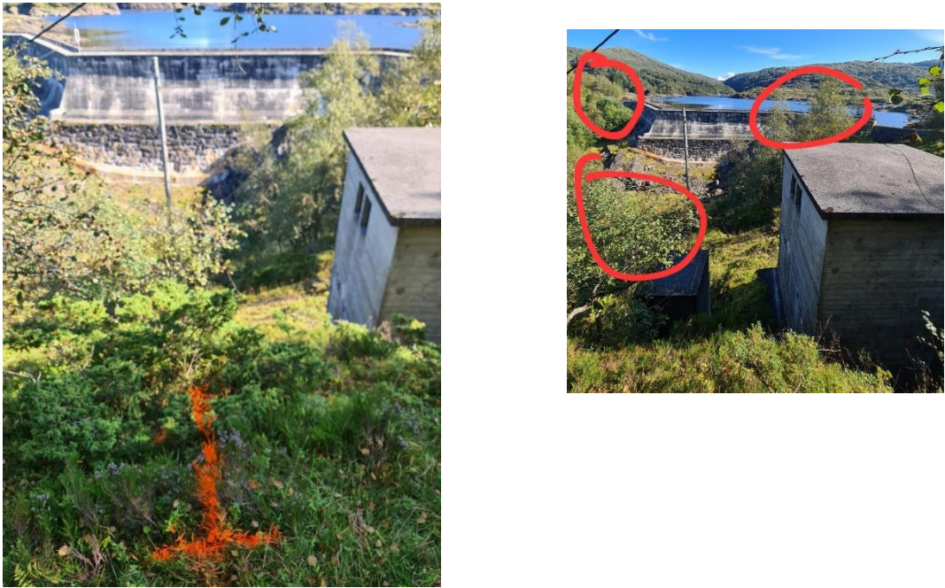
Vedlegg 6: Plassering av betongmålesøyle ved rød spray merking. Fjerning av tre for å sikre fri sikt ved deformasjon måling av dammen røde merking.
