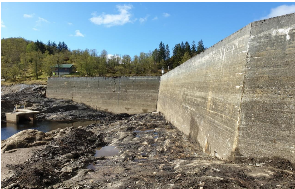
Bilde 2: Viser den dypeste delen av dammen på vannside og inntaket. Denne delen av dammen skal forsterkes med betongpåstøp.
