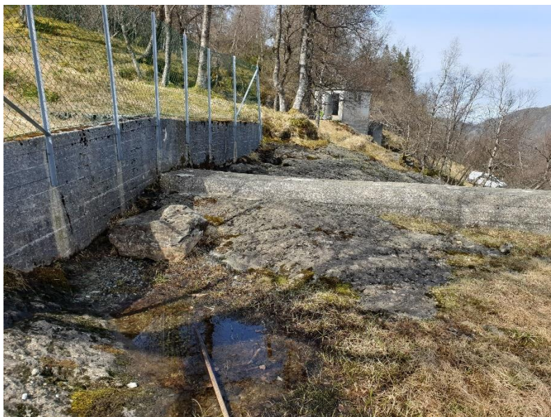
Bilde 3: Sikringstiltak ved dagens overløp.
