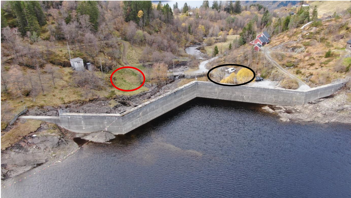
Bilde 4: Dronebilde av dammen med markeringer: Rød sirkel viser området hvor det er behov for erosjonssikring etter senkning av overløp. Svart markering viser området hvor vegetasjon må fjernes for oppstilling av betongbil. Eviny er grunneier.
