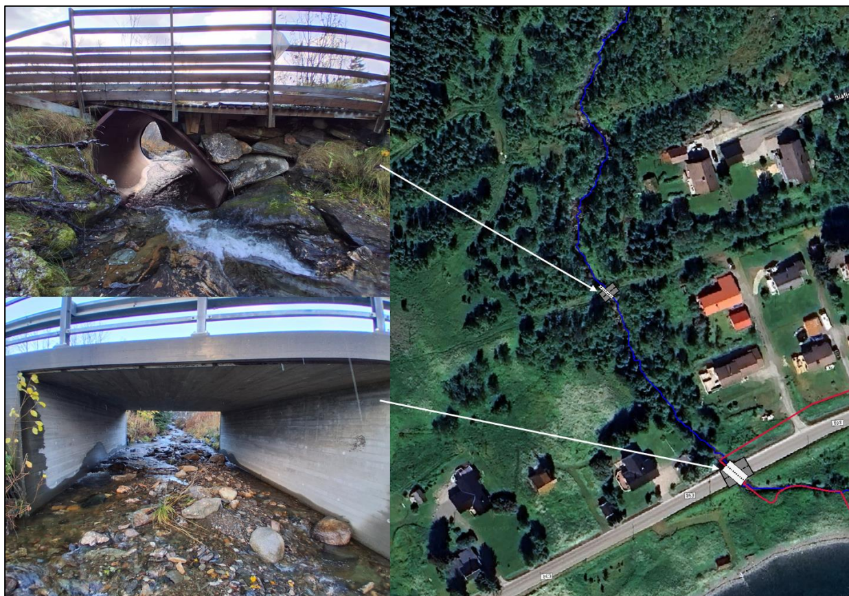
Figur 4-3 Kart og bilder av vanngjennomløp kulverter og bruer i kartlagt strekning.
