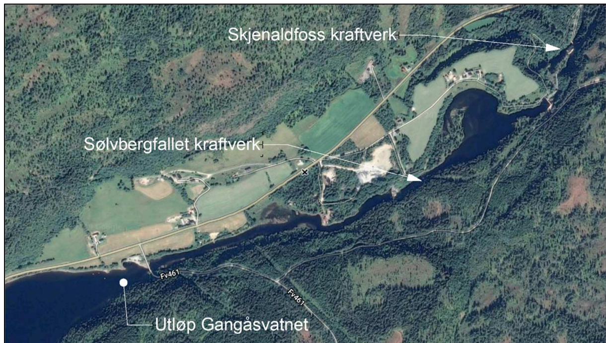
Figur 5: Utløp og kraftverk
