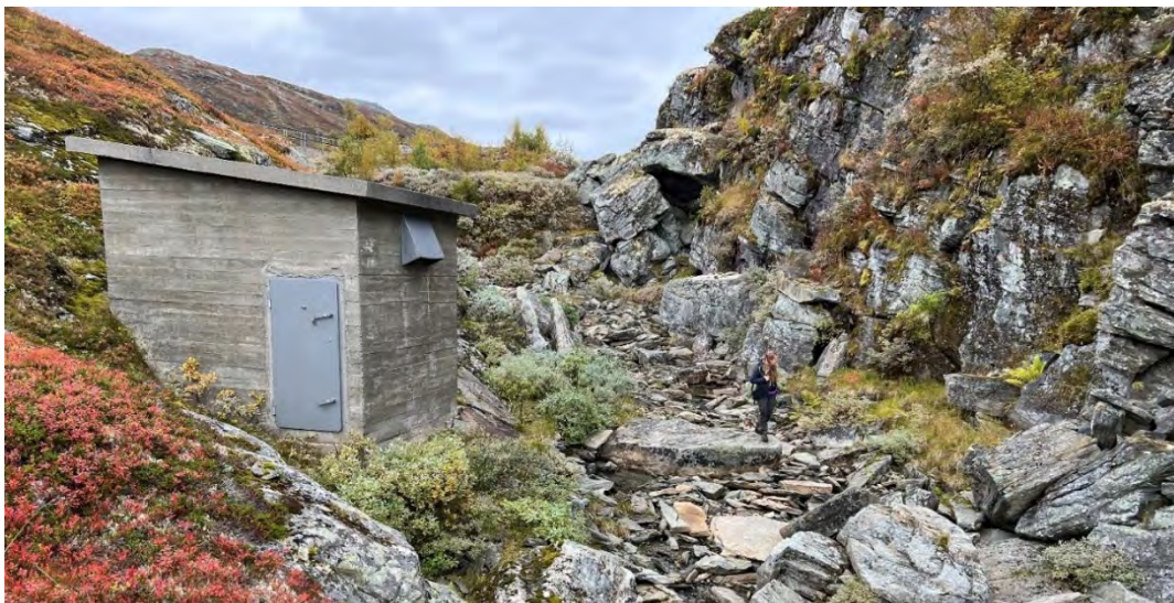
Figur 6-3. Lukehuset ved Rya. Oppstillingsplass for kranbil blir anlagt nordvest for lukehuset (til venstre i bildet)
