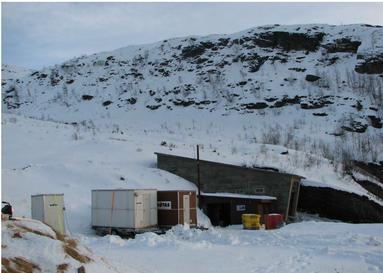
Figur 7-1. Det flate partiet på tipp Nausanosi, vil bli benyttet til rigg.
