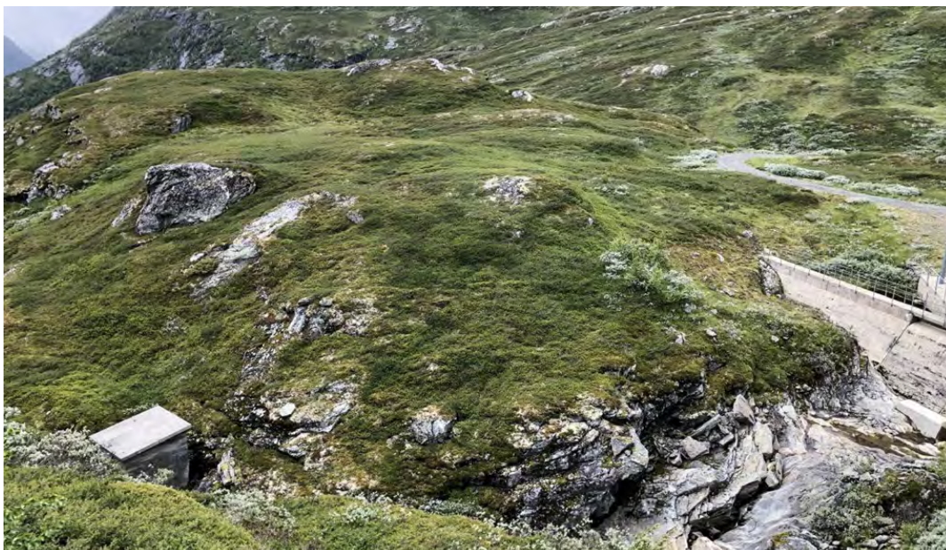
Figur 6-2. Lukehuset til venstre i bildet, bekkeinntaket til høyre.
