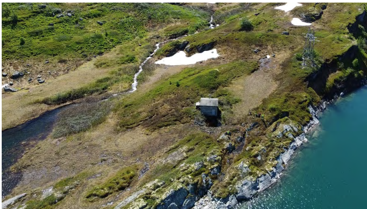
Figur 8-2. Ny adkomstvei og oppstillingsplass som anlegges ila. 2023 vil bli benyttet i forbindelse med arbeider på lukehuset.
