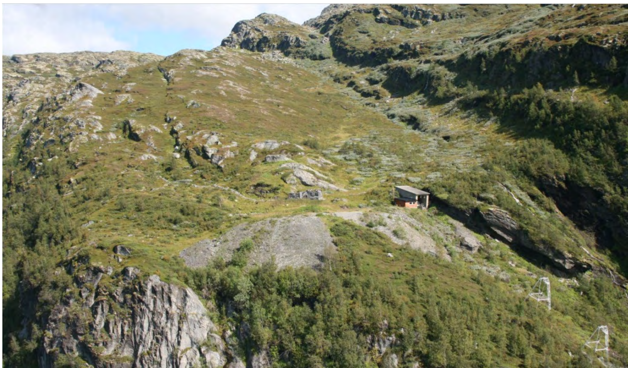
Figur 7-2. Oversiktsbilde over tipp Nausanosi. Den øvre delen av taubanen kan sees til høyre i bildet.
