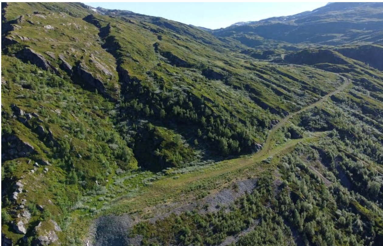
Figur 4-1. Det er planlagt å benytte det flate partiet på tipp Gjessingane til å mellomlagre masser fra arbeidene med vannveien. Området vil også benyttes til rigg.
