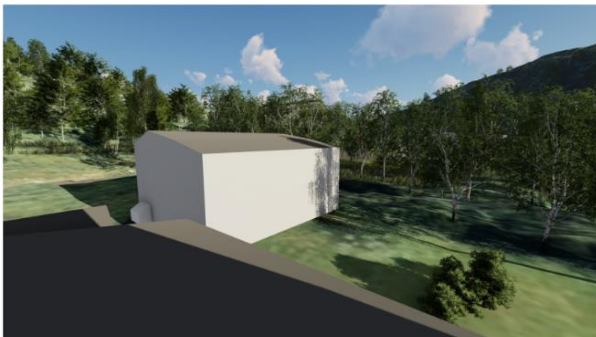
Figur 5-18: Visualisering 10 – pkt 1.13. Transformatorstasjonen sett fra nærmeste bolighus.
