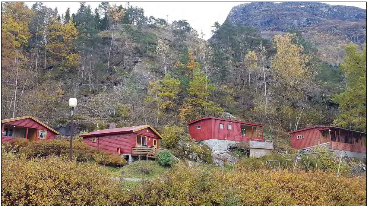
Figur 64: Nærbiletet av fjellområdet ovanfor Loenvatn ferisenter. Fjellet er generelt lite oppsprokke, men det er observert fleire ustabile område som det kan losna steinsprang frå.
