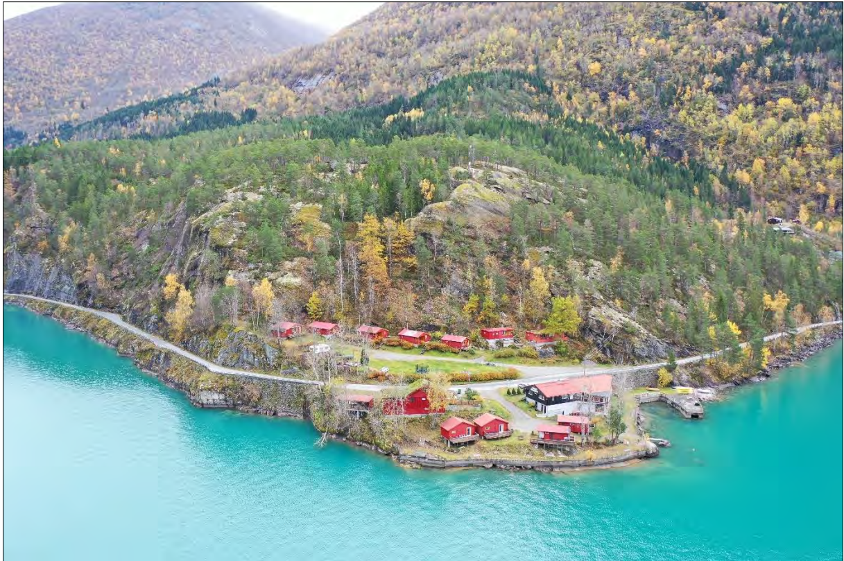
Figur 63: Biletet viser Loenvatn ferisenter som ligg nedanfor eit fjellområde opp til Sandeåsen. Sikringstiltaka som er utført langs fjellskjeringa langs Lodalsvegen kan sjåast til venstre i biletet. Biletet er teke mot nord/nordøst.
