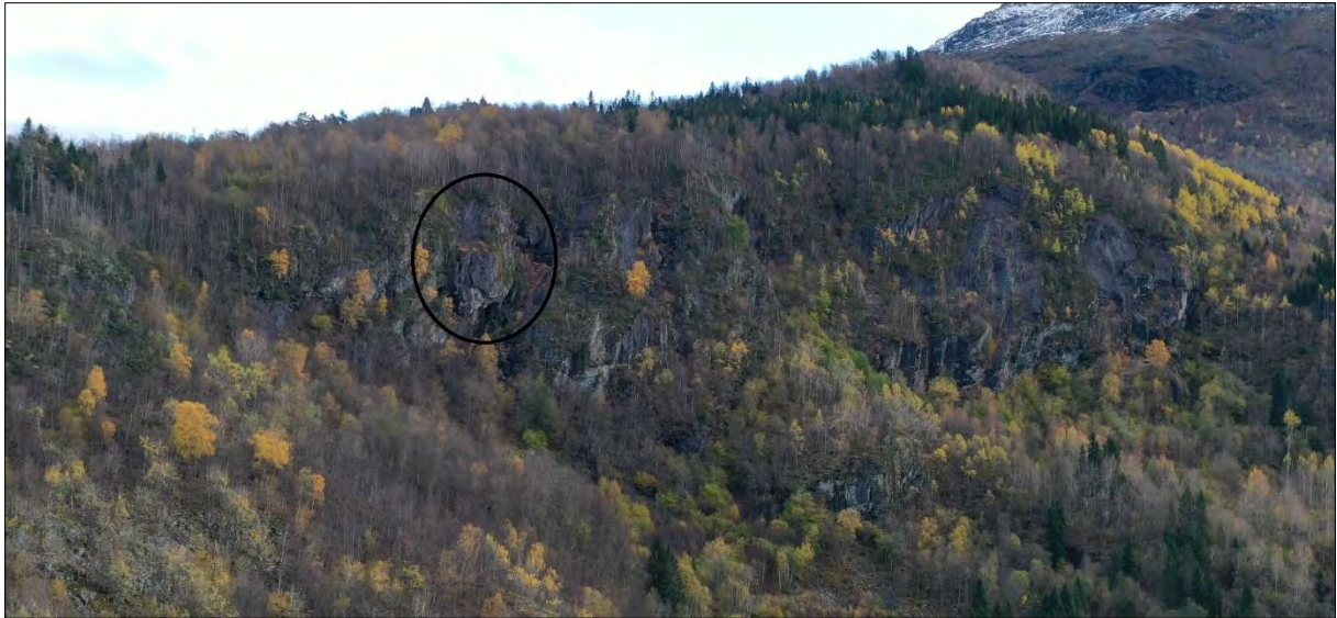
Figur 56: Forstørring av fjellhammaren ovanfor Avleinsvika. Her er det særleg eitt ustabilt område som kan føra til utrasing av stort steinsprang eller lite steinskred.
