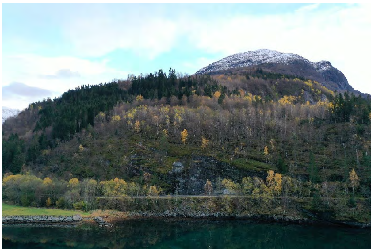
Figur 53: Langs Fjordvegen er det fjellskjering, som har ført til dei fleste skredhendingane i dette området. Biletet viser Engane, og Tyvaneset til høgre i biletet.
