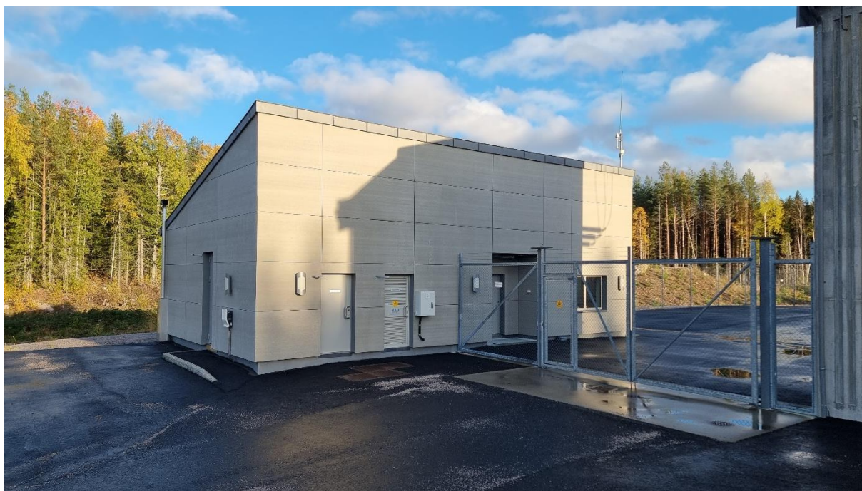
Figur 5: Eksempel på kontrollbygg for Glitre Nett. Her fra Høgefoss transformatorstasjon.
