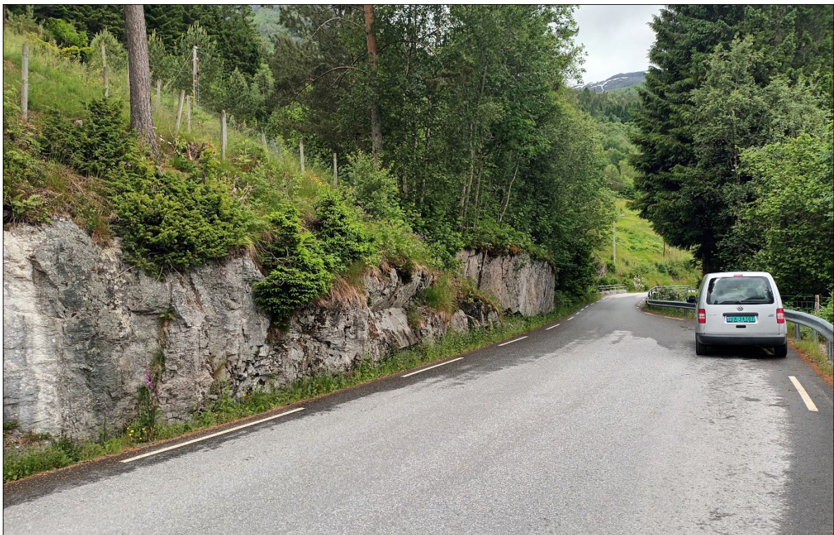
Figur 8: Fjellskjering langs Fv. 5722, Flovegen. Skjeringa er massiv utan vesentleg sprekkdanning. Lausmassedekket i kartleggingsområdet og påverknadsområdet er tynt, vurdert å vere mindre enn 0,5 m. Infopunkt 3.
