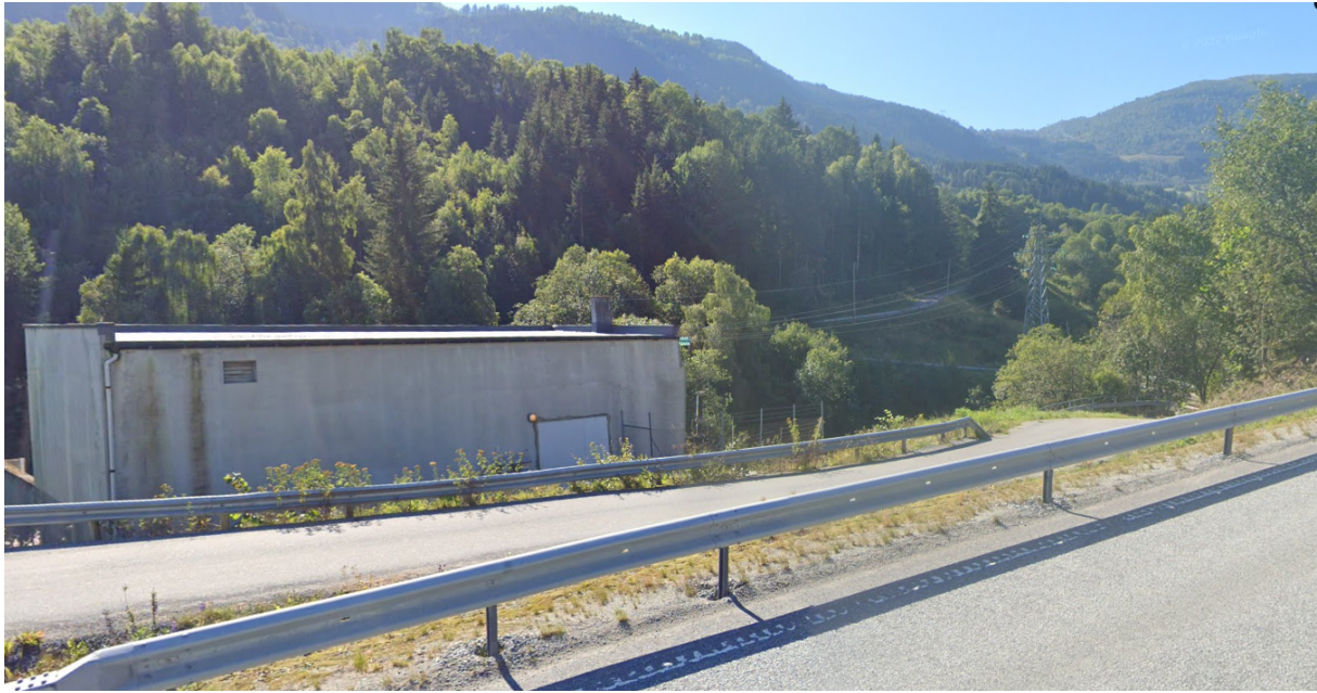
Figur 6: Bilde av dobbeltkursmast ved dagens Kvåle transformatorstasjon: Kilde: Google Maps
