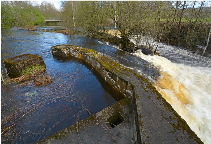
Demningen ved Mølladammen – inntak til BV elektrisitetsverk.
