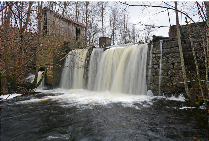
Åmotsaga – demningen med inntak til rørledningen.
