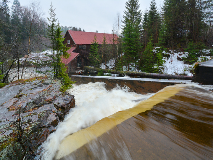
Guriby Sag med rørledning.
