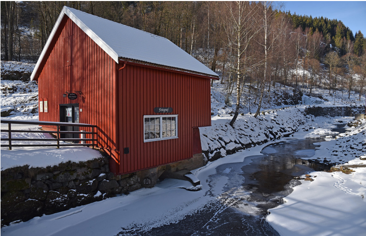
Verksfossen elektrisitetsbygningen - turbinbygningen.
