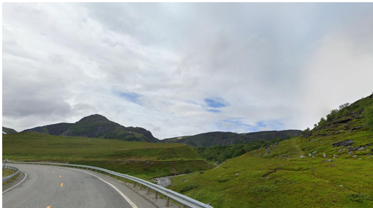
Figur 5-3: Gløtt inn mot prosjektområdet fra E69 og vestover ved Indre Sortvik. Kilde: Google maps street view.
