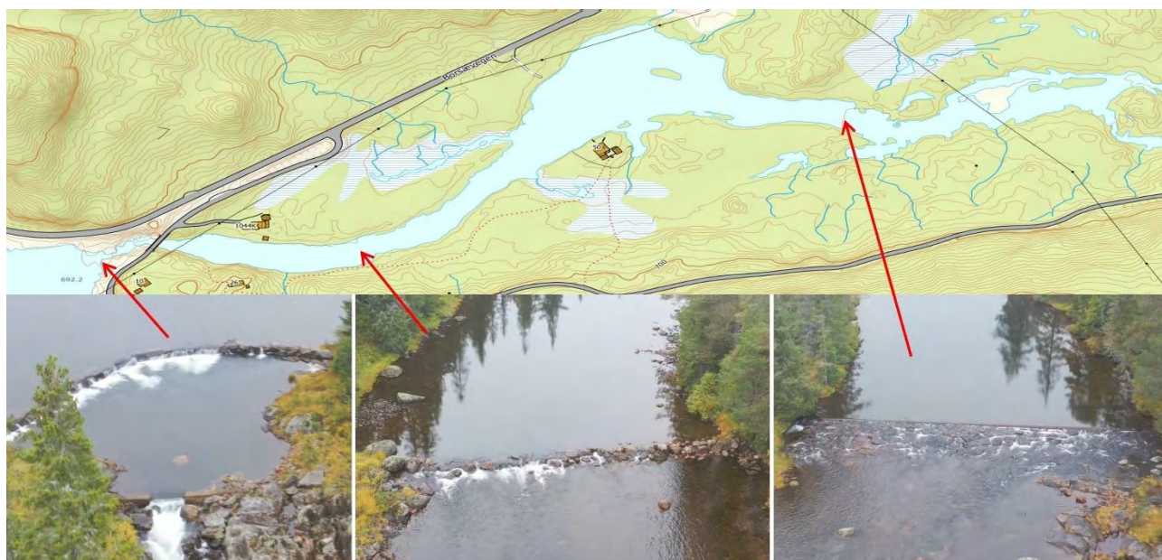
Figur 36. Det er bygget tre terskler ved og nær Grotstøylhylen. Den øverste av disse (terskel med utsparring oppstrøms liten foss), beliggende rett oppstrøms der Stridsmovegen krysser elva med bru, er vurdert å kunne være absolutt vandringshinder for oppvandrende gyteørret. Vannføring på fotoene er beregnet til 1,0 \text{ (mvf)} + 0,16 \text{ (restfelt)} = 1,16 \text{ m}^3/\text{s} .
