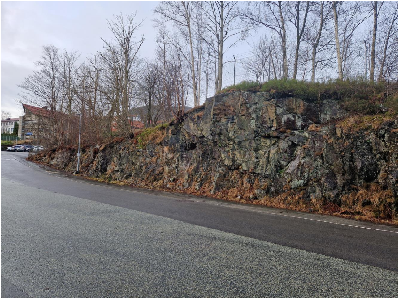
Bilde 11. Bergskrent/skjæring på vestsiden av kartleggingsområdet. Noe oppsprukket berg og sprekkeplan med helning ned og inn i skjæringen. Sett mot sørvest.
