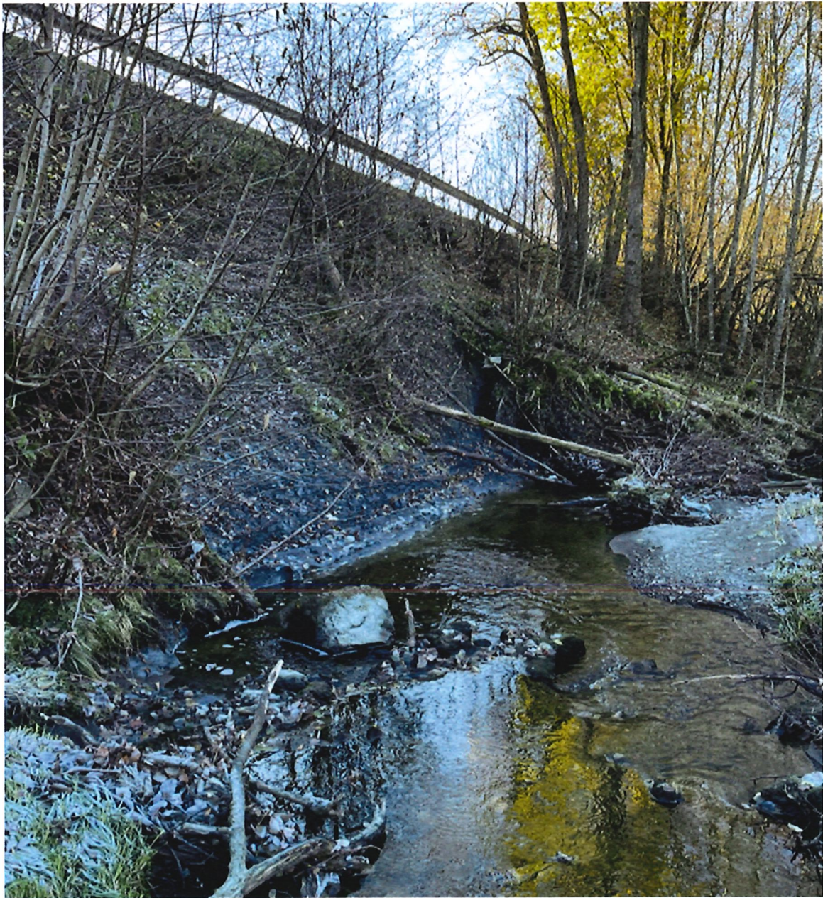
Figur 10 Erosjonsskader langs bekken nedenfor Volvegen
