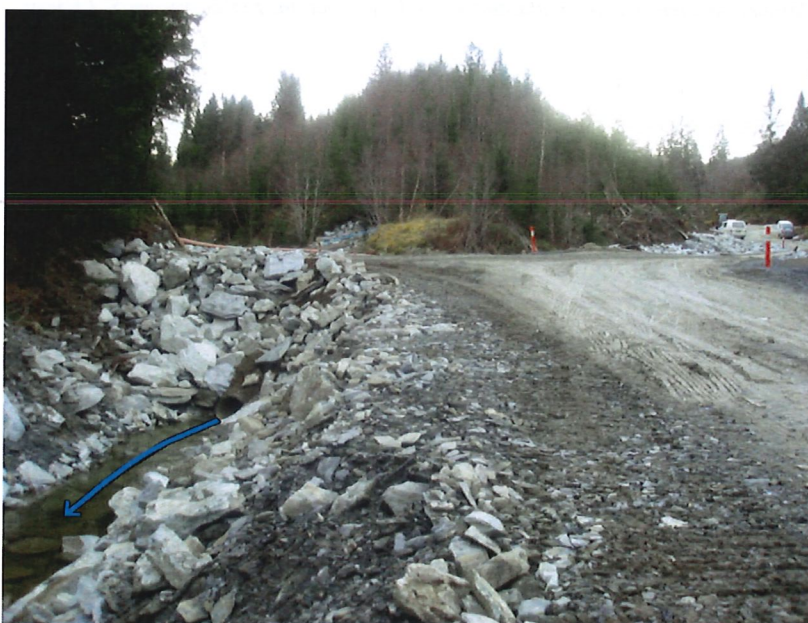
Figur 5 Midlertidig sikret løp (sider og bekkebunn) i Sunndalsbekken, Trondheim kommune. Figuren er hentet fra NVEs sikringshåndbok, modul F3.206.
