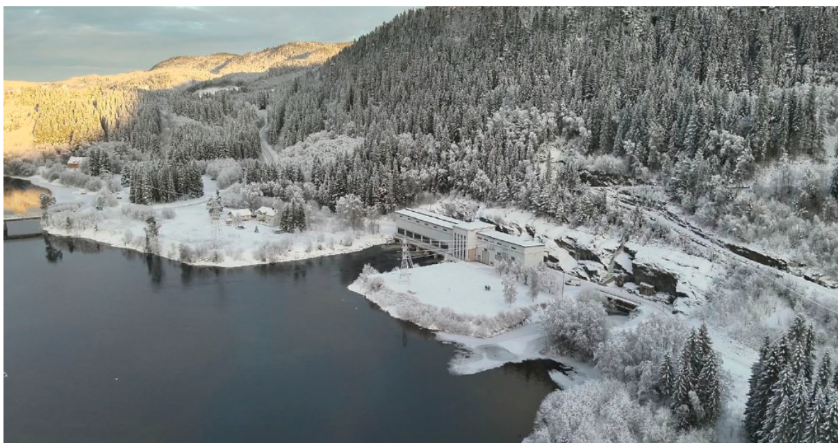
Figur 2: Dagens Svean kraftverk. Nytt kraftverk i fjell med utløpskanal bygges til høyre for eksisterende stasjonsbygg.
