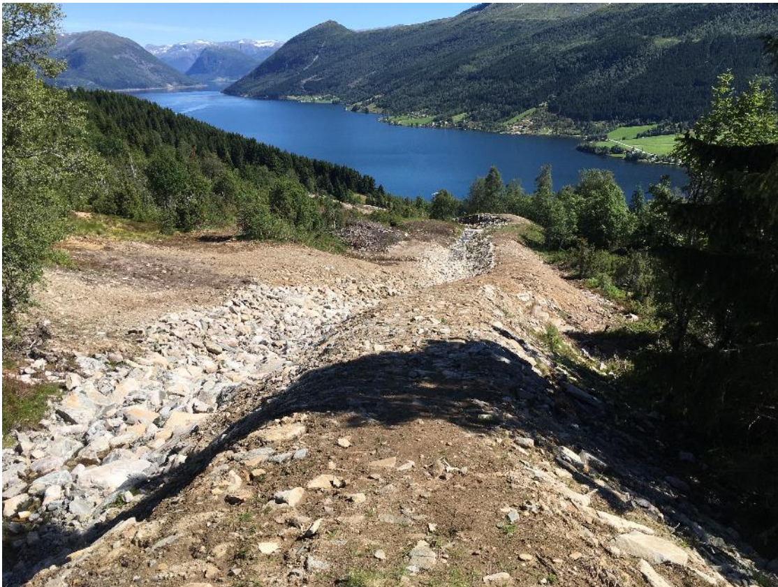
Figur 12 Ledevoll for å hindre at Årsetelva går til høyre mot boligfelt. Etter hendelsen lå det mye masser i foten av vollen. Nå er denne massen fjernet, trolig dels lagt opp på vollen og på ytterside. Løpet er plastret videre nedover.
