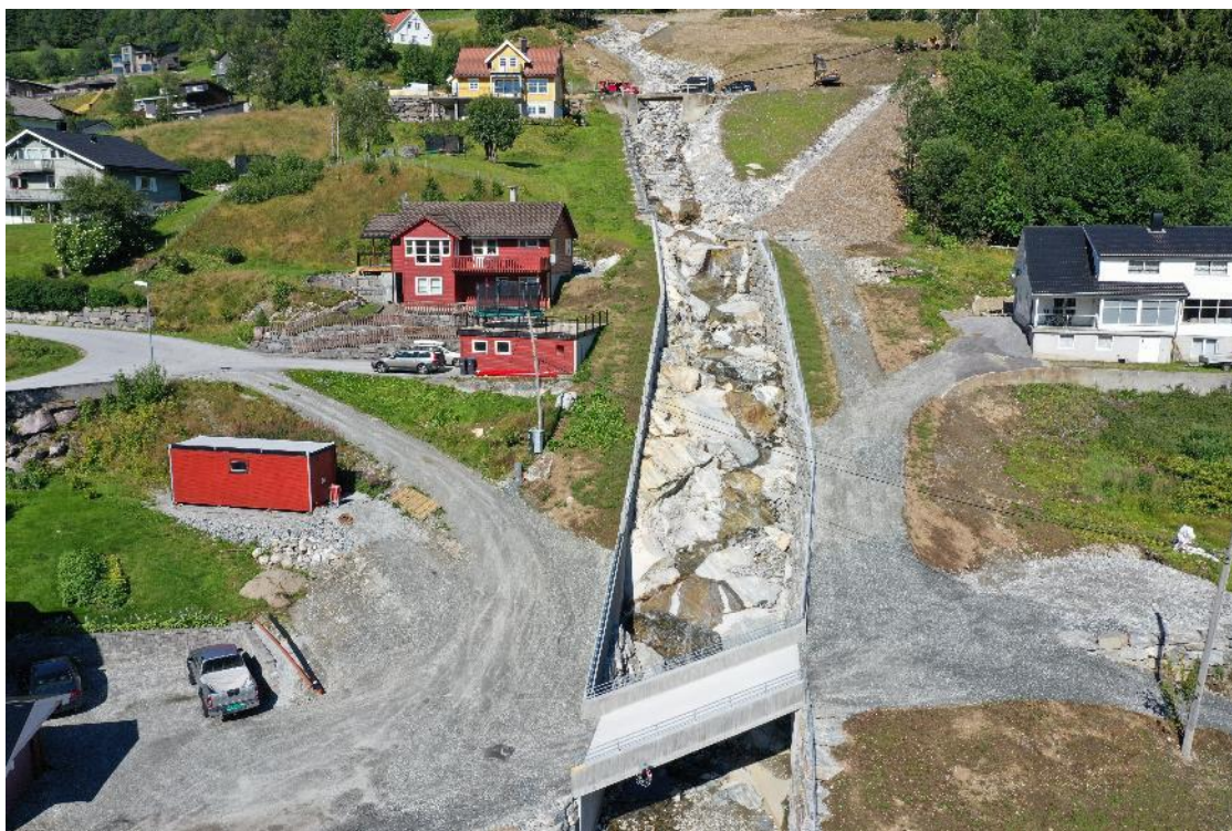
Figur 4 Nedre del av sikret elv. Elva er rensket ned på berg i et lengre parti. Ovenfor det hvite huset er det nå anlagt en slak ledevoll. På motsatt side av kanalen var rødt hus utsatt for erosjon. Denne delen av elva hadde lite synlig berg i elvekanalen før hendelsen.
