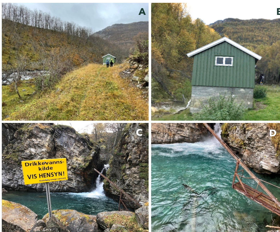
Figur 4: A – Vei inn til silhuset; B – Silhuset; C - Inntaksbasseng Stelfossen; D – PE inntaksrør i bassenget (Foto A og D: T.-E. Iversen; foto B og C: H. Kvitsand).
