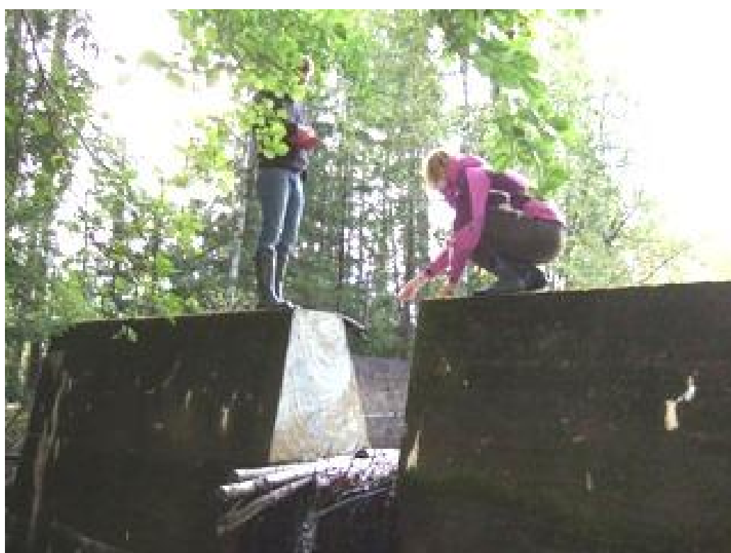
Figur 12. Midtre Askdam. Overløp senket med 1,0 m. Høsten 2011
