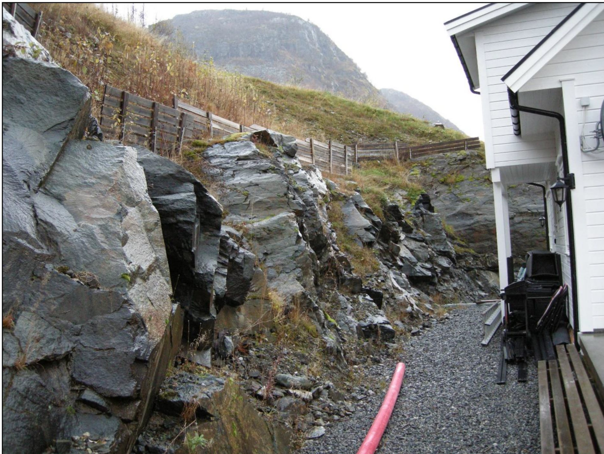
Figur 12: Eksempel på terrenginngrep bak ett av husene i boligfeltet. Sognemur er etablert for å redusere fare for nedfall av blokker rundt huset, samt redusere sig og fare for utglidning av løsmassedekket.
