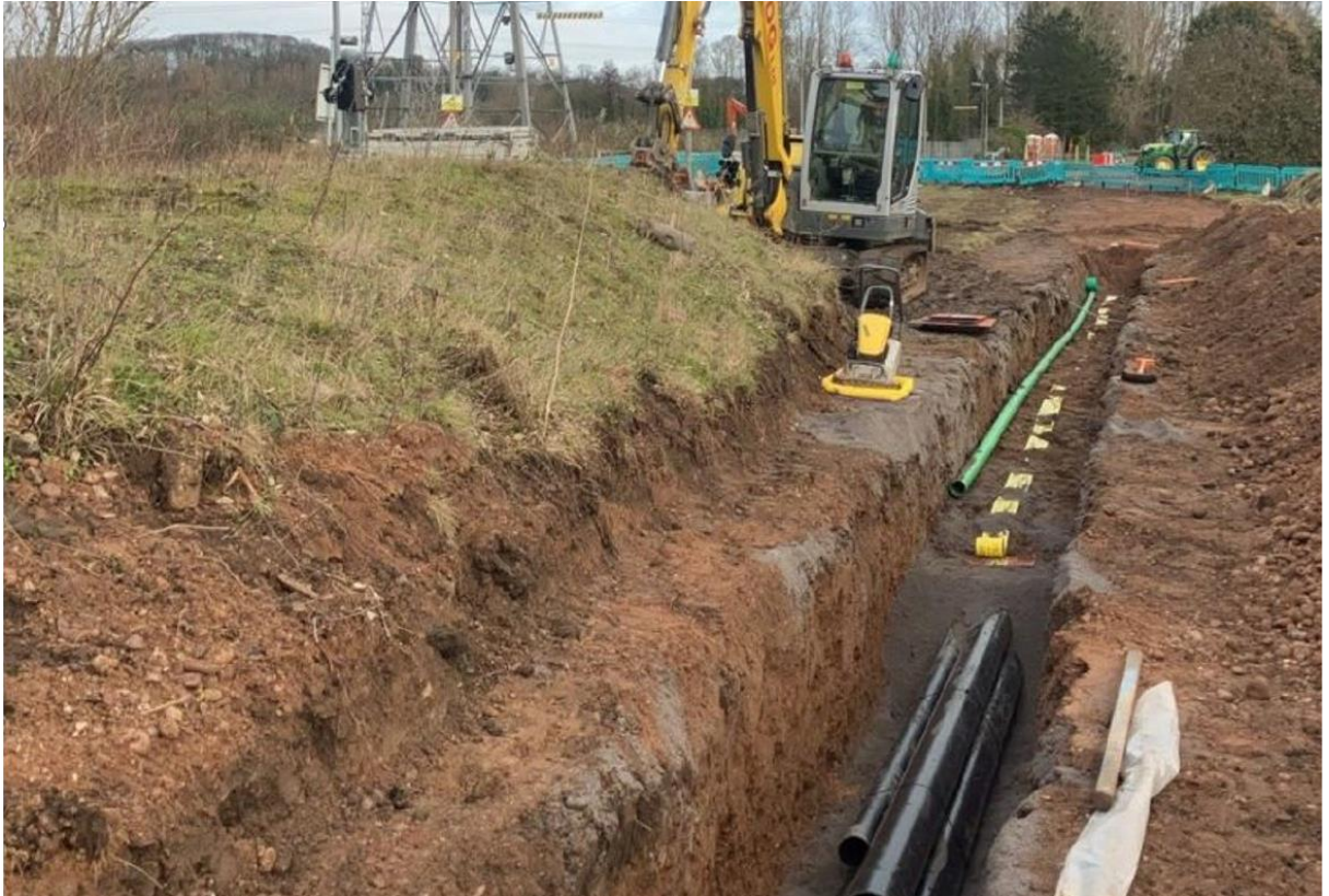
Figur 1. Eksempel på kabling av 132 kV jordkabel.
