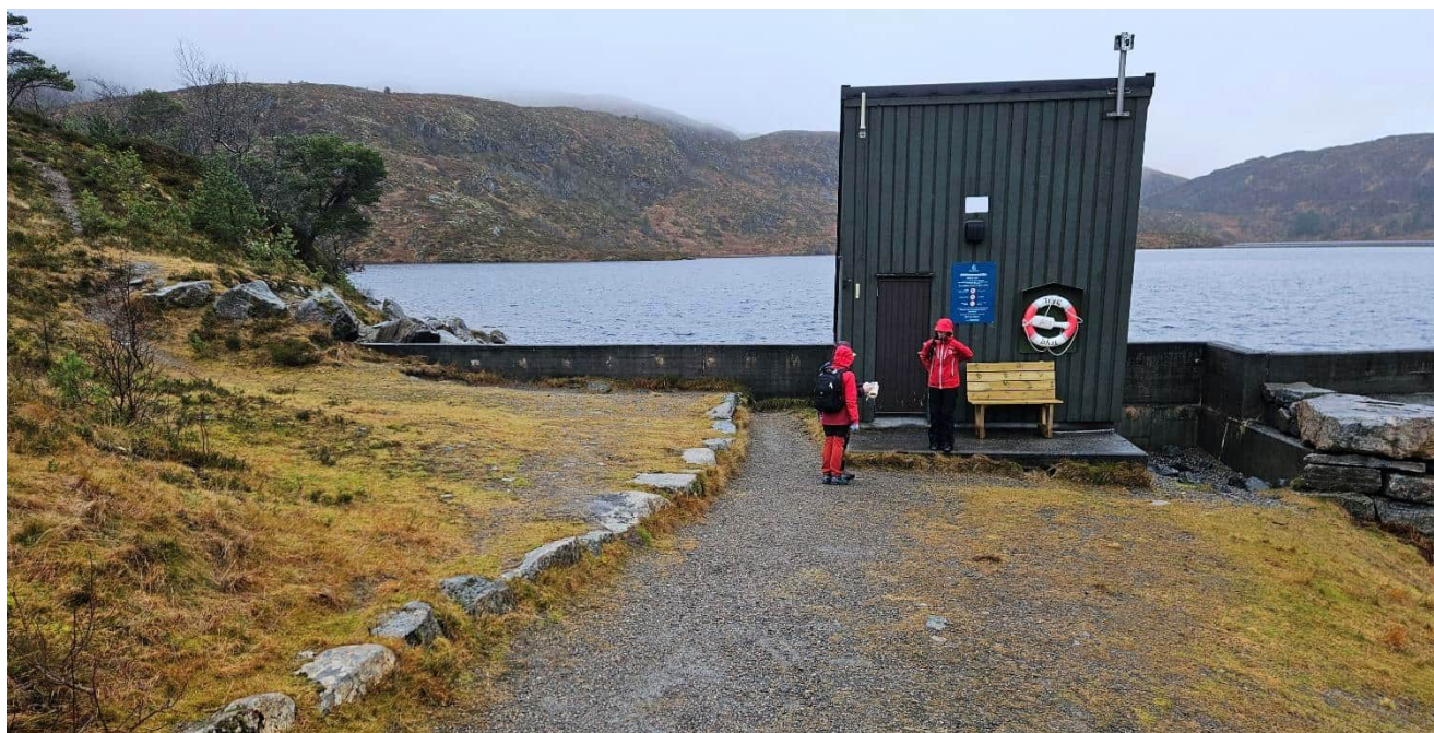
Figur 3.3 Riggområde 1 hvor det er en liten steinsatt høydeforskjell mellom to grusede plasser som kan bli aktuell å midlertidig jevne ut. Bruk av duk på det i dag bevokste området kan være aktuelt.
