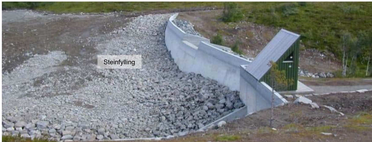
Figur 3.1 Nedtappet magasin i 1999 ifbm. reparasjon. Steinfylld mot dam vil antagelig bli benyttet som anleggsveg i byggeperioden.
