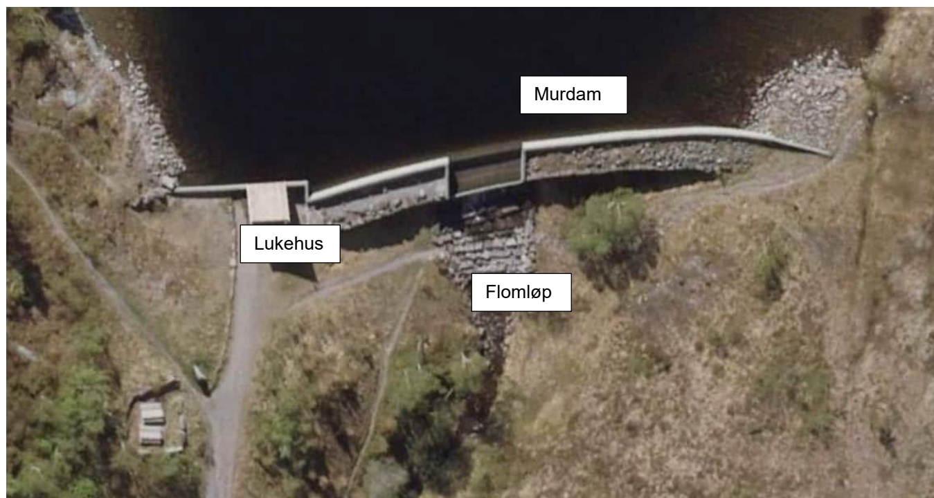
Figur 1.3. Eksisterende dam Moldevatn, oversikt (finn.no, flyfoto fra 2022).
