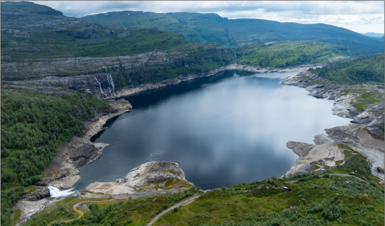
Figur 1-4. Bilde av reguleringsmagasinet Kvitingsvatnet tatt fra nord mot sydvest. Dagens kraftverksutløp er til venstre i bildet. Bilde: Sweco.
