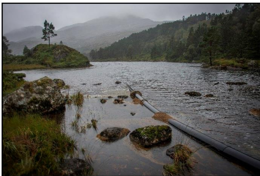
Figur 2: Inntak i Skogevatnet
