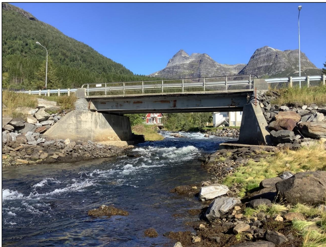
Figur 24: Den berørte delen av elva sees nesten i sin helhet på bildet. Inntaket ligger oppstrøms den lave utstikkeren på den venstre bredden ovenfor broa. Røret vil komme på venstre siden av elva, under brua og gå ned i sjøen. Bildet er tatt ca. på flomålet. Foto: Hildur Søndergaard
