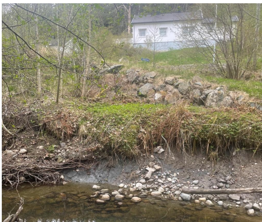
Figur 7: Det ble funnet noe erosjon i bekken hvor det graves i underliggende leire rett ovenfor parkeringsplassen.
