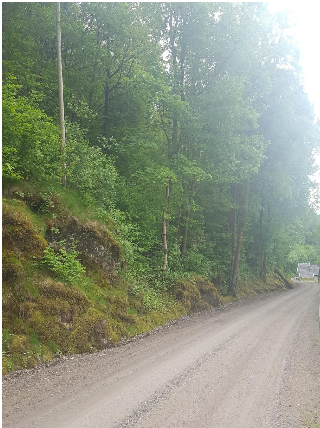
Bilde 2. Fra område 2 i figur 3. Skråning ned mot Fv. 553.
