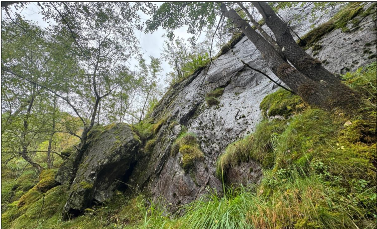
Figur 11: En representativ del av skrenten som ligger rett øst for kartleggingsområdets avgrensning. Berget er jevnt over ganske glattskurt med få avgrensede bergblokker. Likevel finnes det enkelte partier som er sprekkeavgrenset og som kan komme i bevegelse
