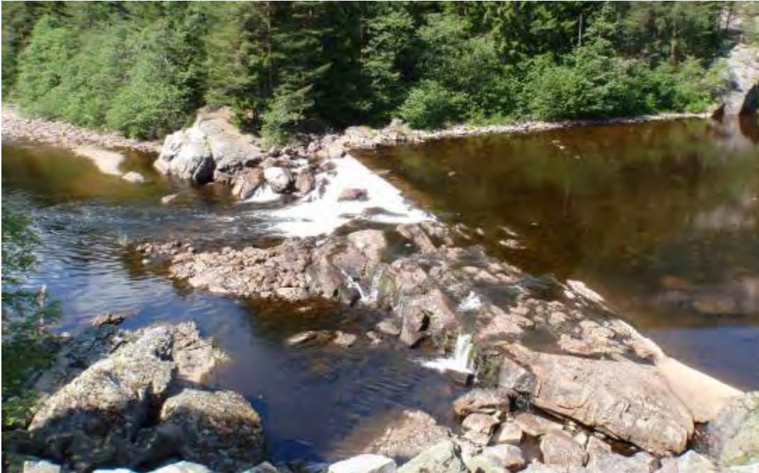
Figur 10. Terskel nedstrøms Satajuvet, ved vannføring ca. 2,3 m 3 /s. Foto er hentet fra Skagerak Kraft (2018, upubl.).
