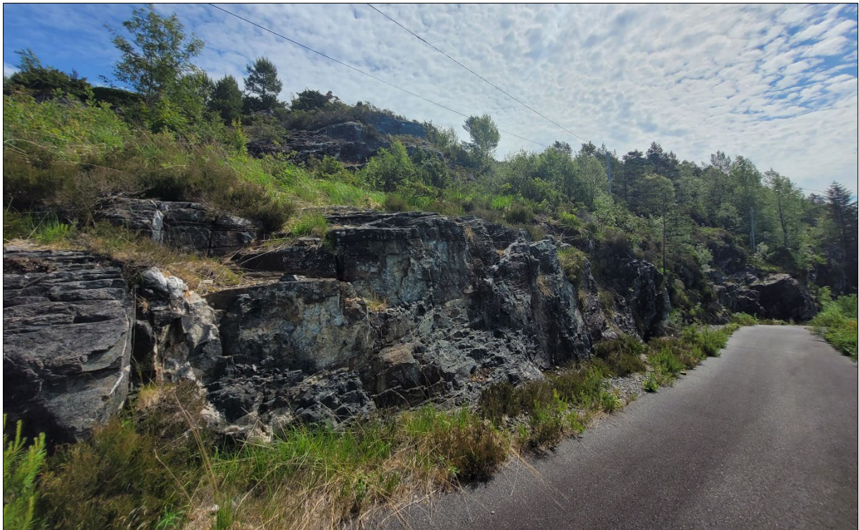
Figur 18: Kombinasjon av gunstig orientering av dominerande sprekkplan langs foliasjonsplana og låg høgde på skrent (< 2 m) gjer at skrenten her ikkje vert vurdert som losneområde for steinsprang med skadepotensiale. Infopunkt 4.
