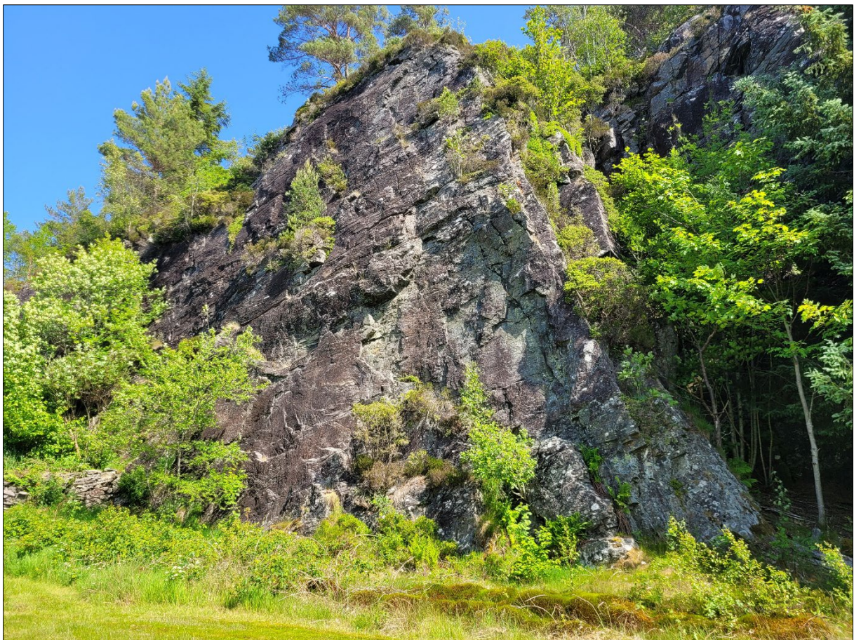
Figur 4: Biletet viser området der det skal etablerast renovasjonsanlegg, nedanfor ein inntil 20 m høg fjellskrent. Infopunkt 13.
