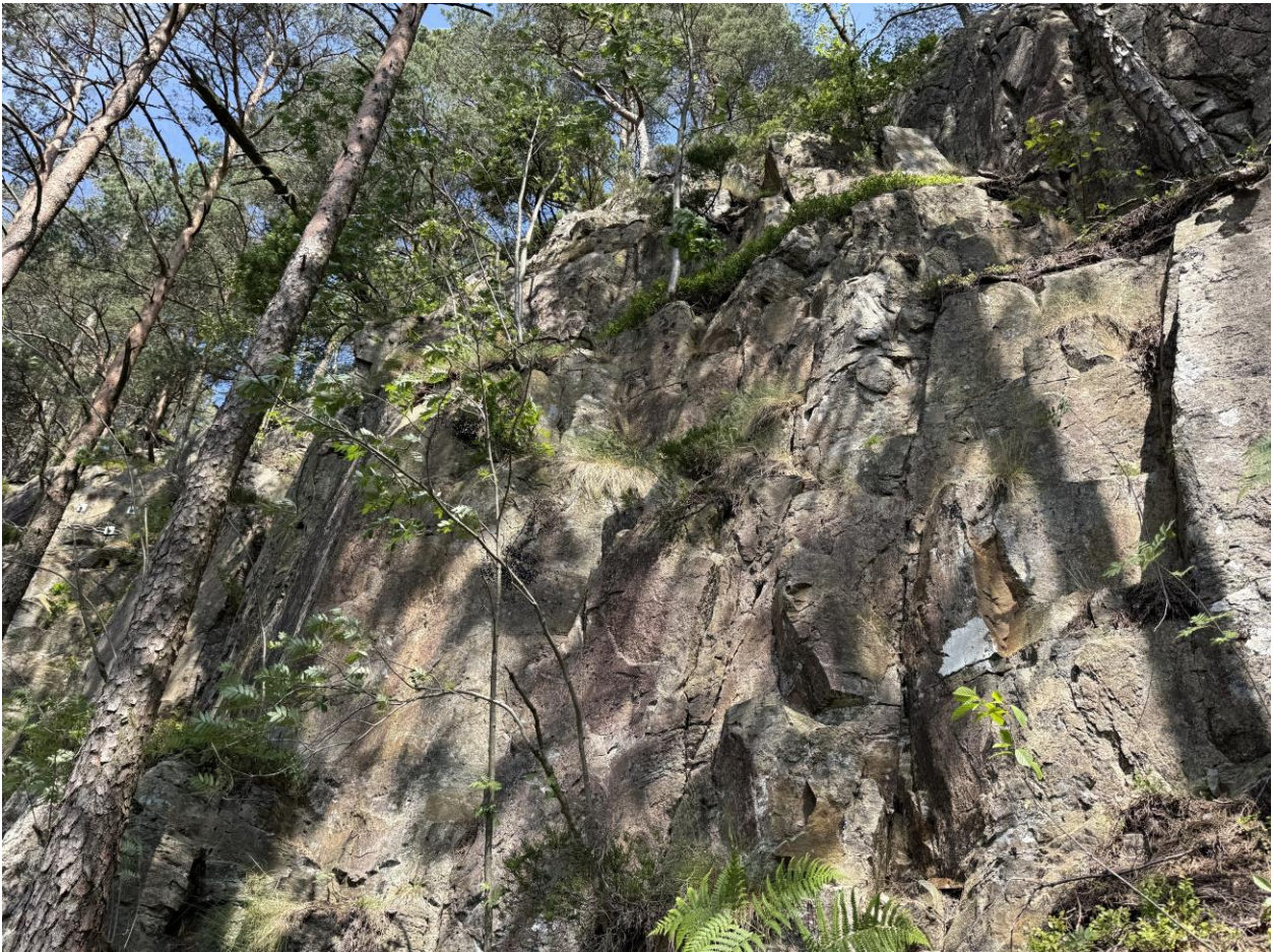
Figur 8. Bratte skrenter i påvirkningsområdet. Lavt løsnepotensialet.
