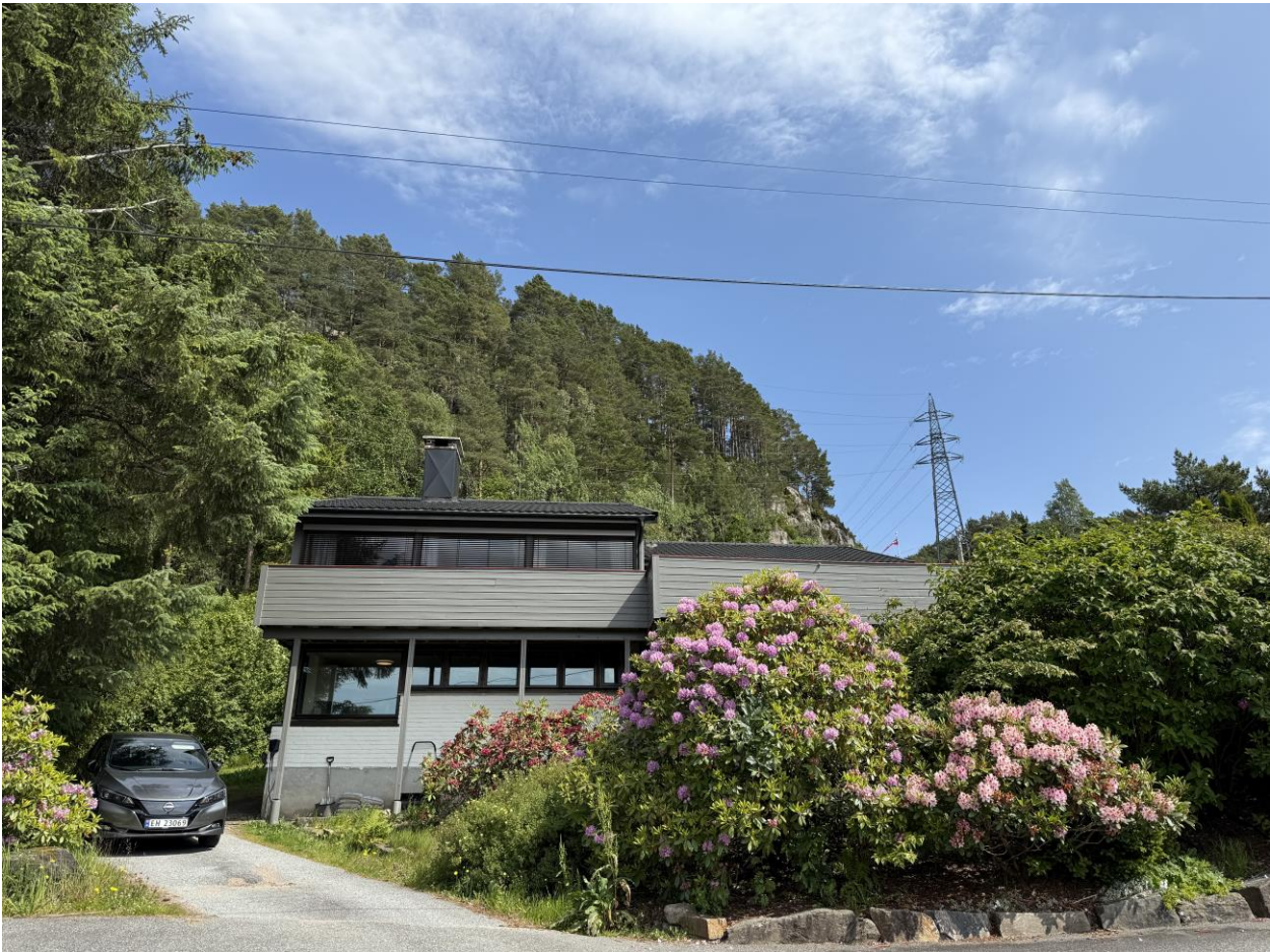
Figur 3. Eksisterende bolig på eiendommen. Det skal foregå en bruksendring av underetasjen. Bildet er tatt mot øst.
