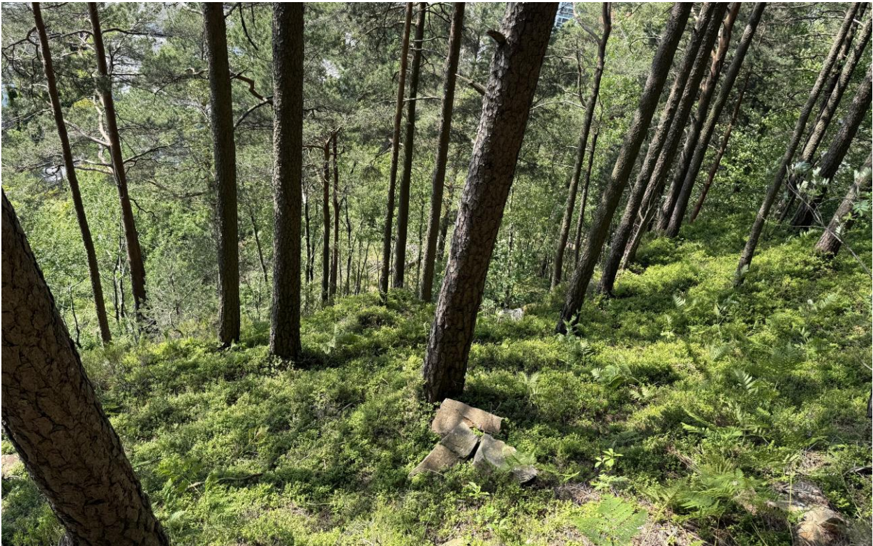
Bilde 3. Eksempler på nedrenskede blokker. Blokkene er lagt stabilt i terrenget nedenfor skrentene. Bildet er tatt mot vest.
