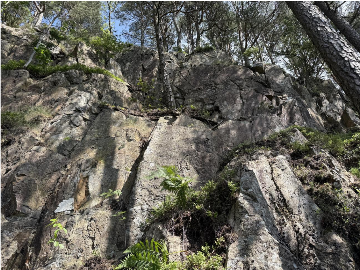
Figur 9. Bratte skrenter i påvirkningsområdet. Lavt løsnepotensialet.
