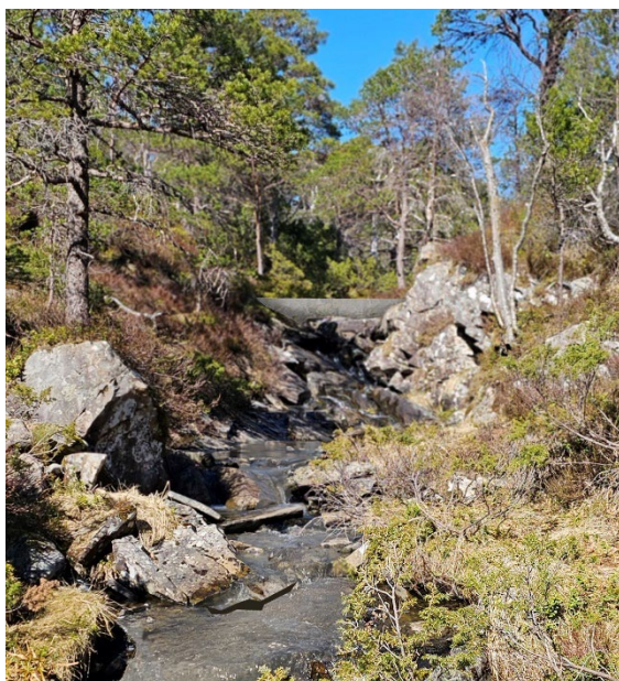
Figur 5-18: Manipulerte bilde viser eksempelvis plassering av bekkeinntak med visuell virkning. Til høyre eksempel på prefabrikkert inntaksløsning som settes i utkant av bekkestrengen, normalt på vannstrømmen. Nedstrøms vingemuren plasstøpes en vegg på tvers av bekkeløpet, med høyde 0,7 – 1 m.
