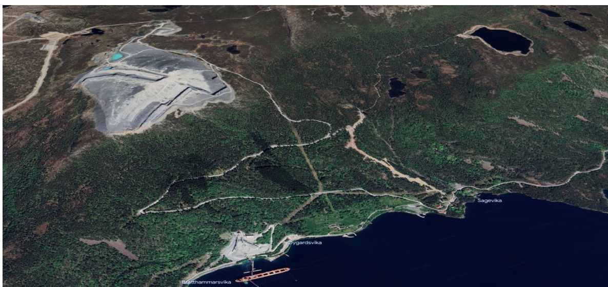
Figur 5-3: Omfanget av inngrepene ved bruddet blir overskyggende der dette oppleves på nær og midlere hold.
