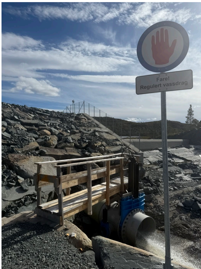
Figur 2-2: Reguleringsdam med flomløp og tapperør
