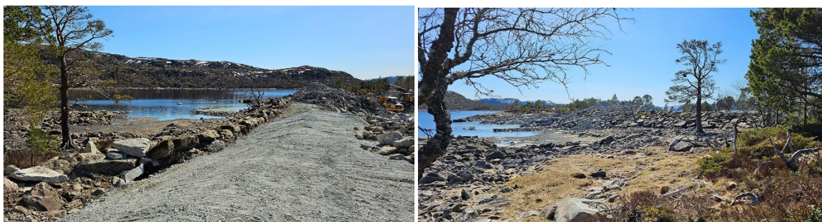
Figur 5-11: Damanleggene ved Dyrstadvatnet har blitt rehabilitert.
