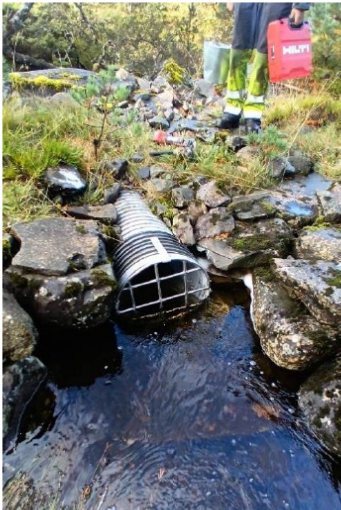
Figur 1-3: Inntaket til dagens overføring
