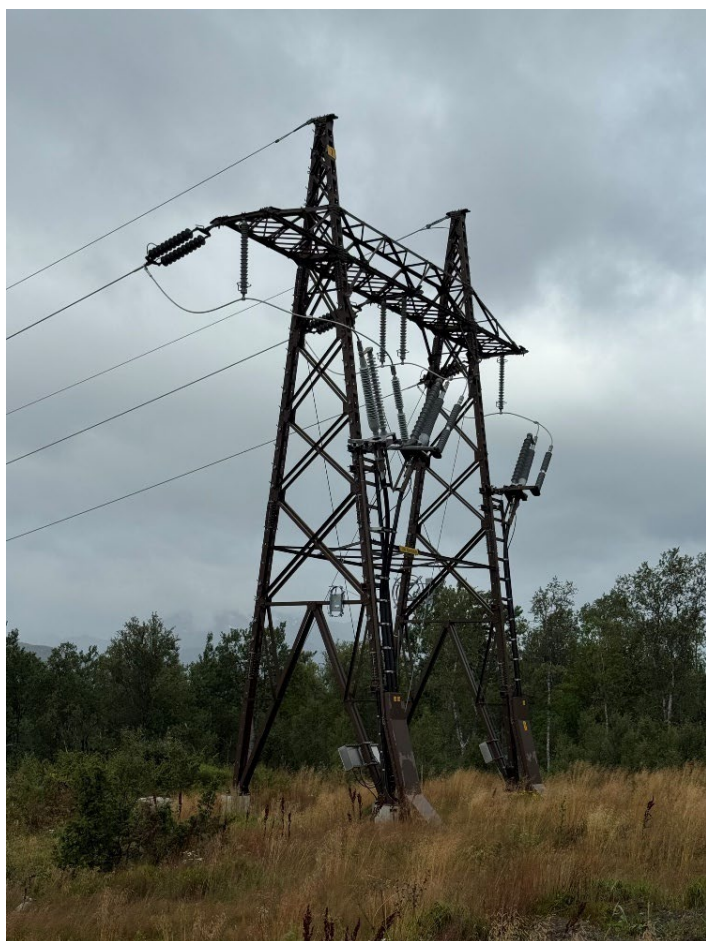
Figur 12 Bilde av aktuell kabelendemast fra Boltås stasjon.
