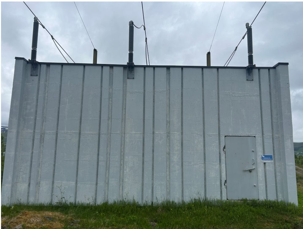
Figur 22 Eksisterende muffehus på Hinnøya. Anleggene planlegges revet og sanert.
