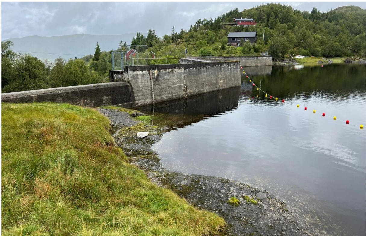
Bildet viser Skulstadvatnet dam sett fra magasinet. Til venstre vises dagens flomoverløp.
