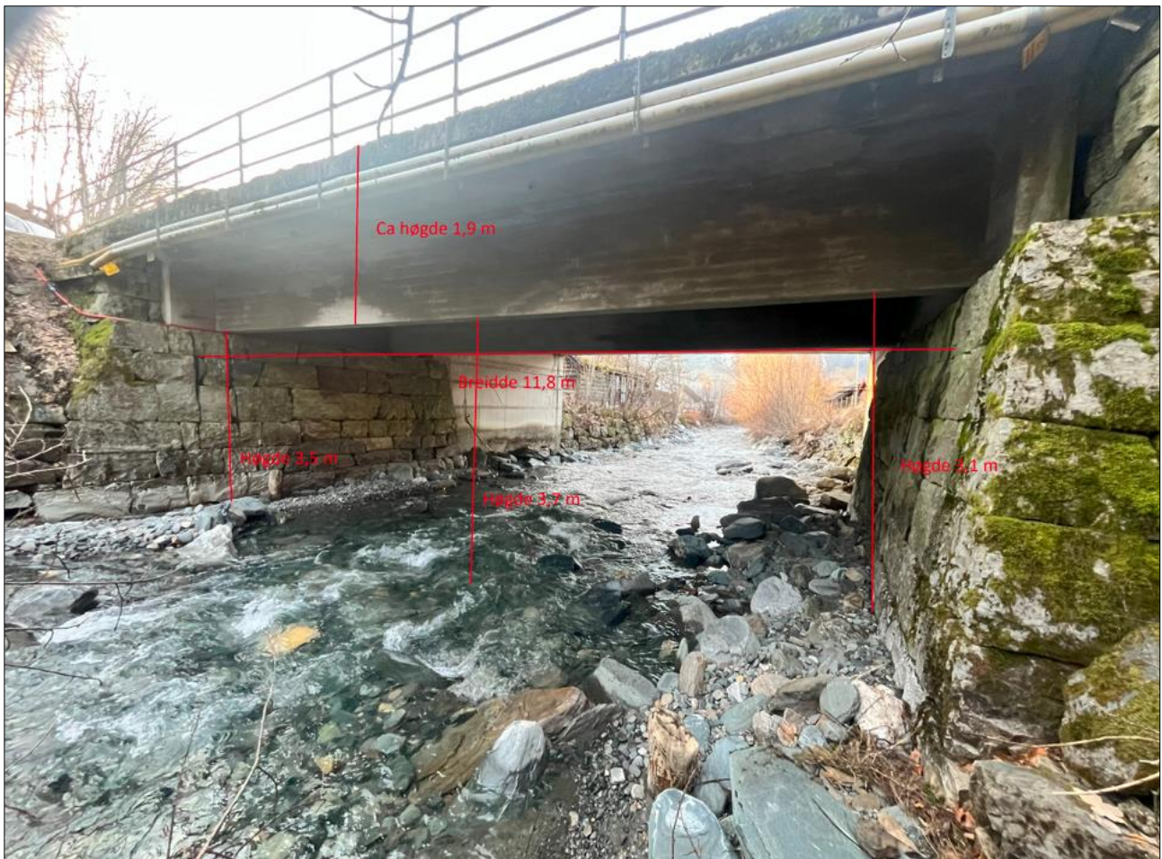
Figur 10 Bru over Rv. 13, oppstrøms side.
