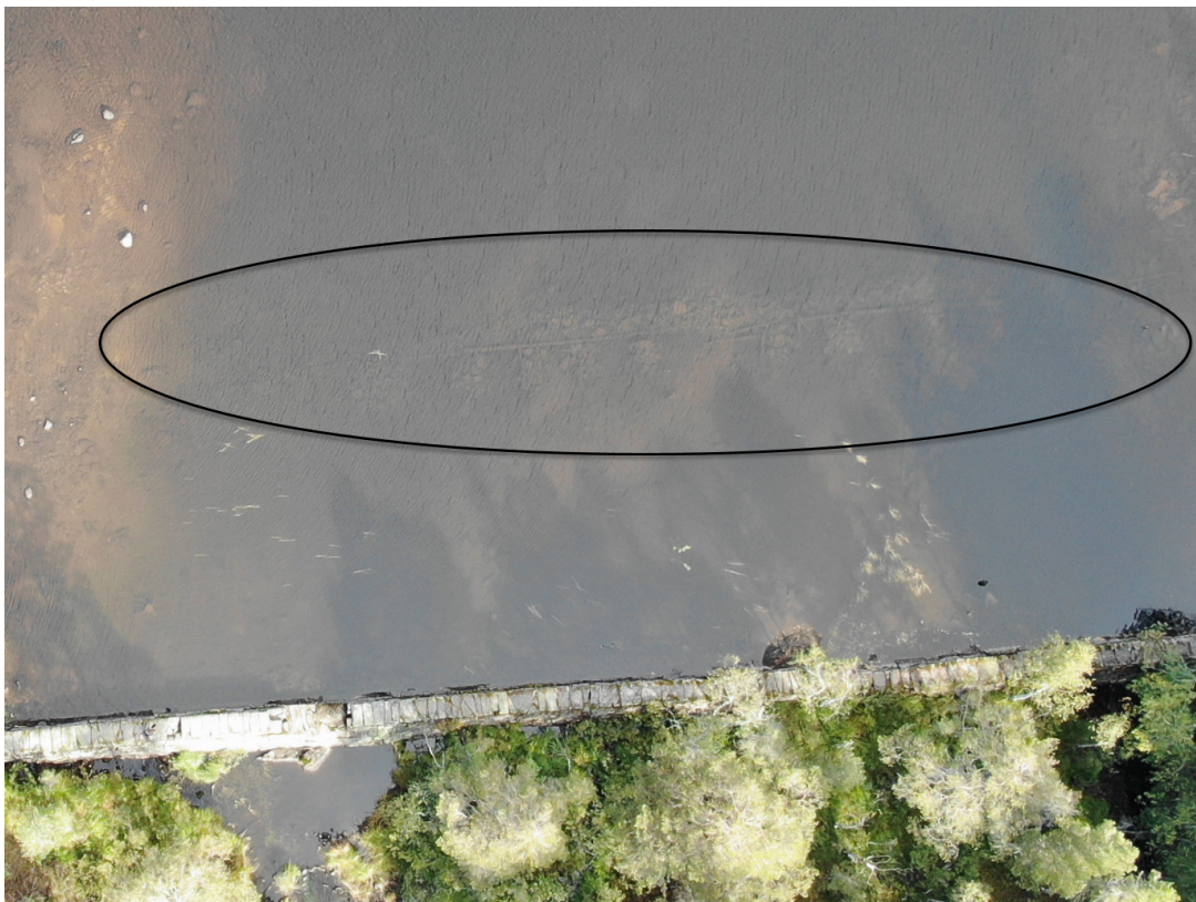
Bilde 5-1: Foto viser konturene av tidligere damkonstruksjon (Øystein Klausen, Vassbygg).
