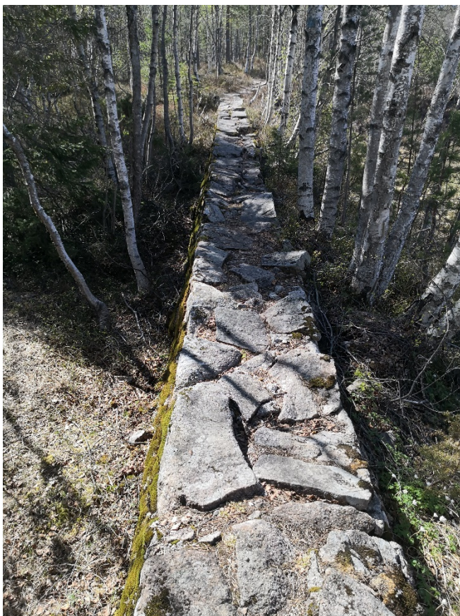
Bilde 9-3 – Dammens østre del
