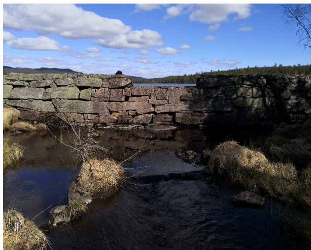
Bilde 9-4 – Eksisterende flomløp
