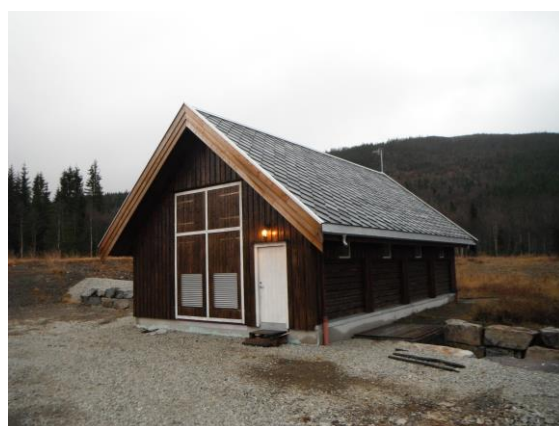
Bilde 8: Litlelva Kraftverk i Namsskogan. Fotograf: A. Kiær.
