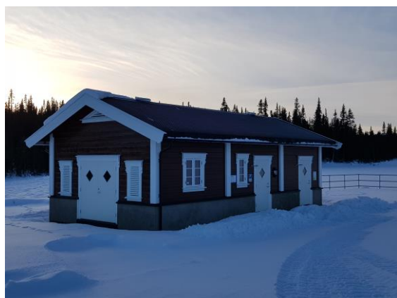
Bilde 4: Inntakshus, bildeillustrasjon - prinsipp. Fra Søkkunda Kraftverk. Fotograf: A. Kiær (2019).
