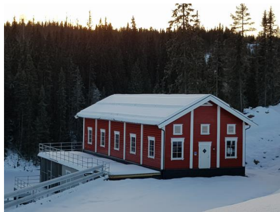
Bilde 7: Stasjonsbygg til Søkkunda kraftverk – slipplatt og sprossede vinduer - illustrasjonsfoto. Fotograf: A. Kiær (2019).
