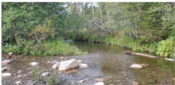
Bilde 5: Område for utløpskanal fra Seterfossen kraftstasjon - til høyre på bildet. Fotograf: A. Kiær (2019).
