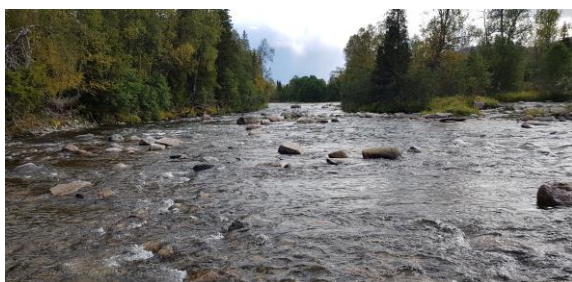
Bilde 6: Område for utløpskanal sett medstrøms fra Seterfossen kraftstasjon. Foto: A. Kiær (2019).
