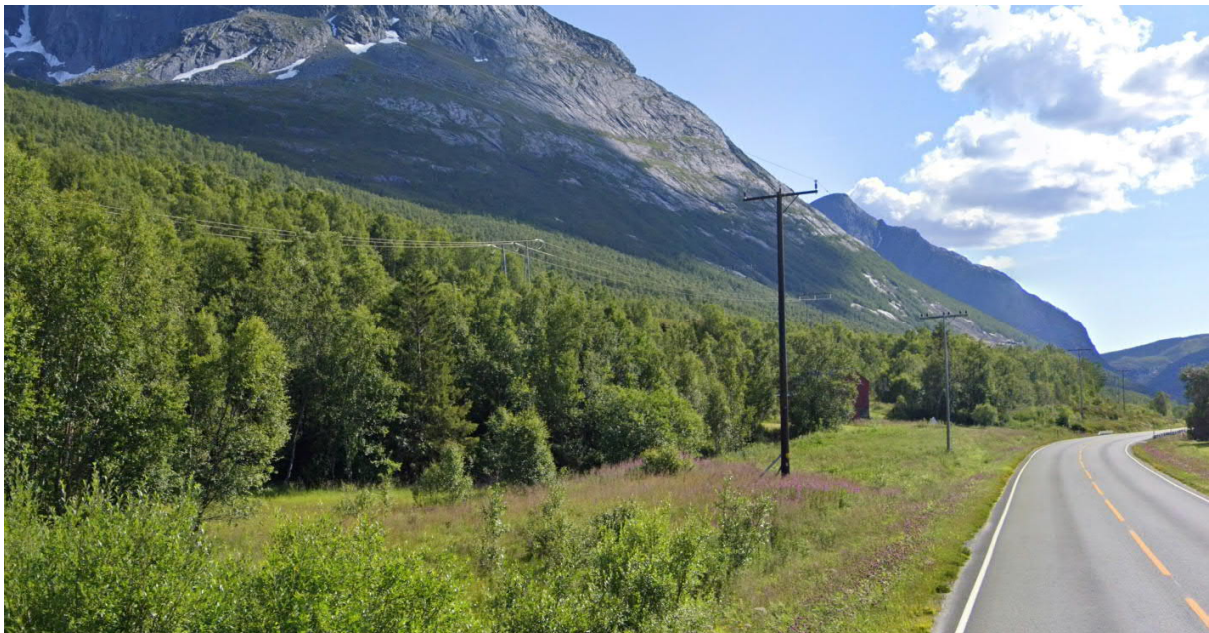
Figur 33 Fra Hellervika og sørover mot Breivika er ny trasé planlagt lagt noe lenger opp i terrenget sammenliknet med dagens trasé som er synlig på bildet. Eksisterende 22 kV nett er også synlig. Kilde: Google maps.
