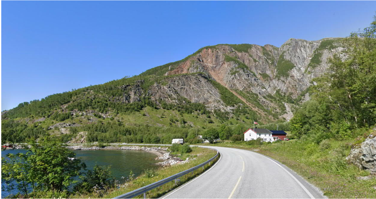
Figur 24 Indre Skålsvik i Gildeskål kommune. Området ligger innenfor landskapstype relativt åpent fjordlandskap med bebyggelse/infrastruktur . Landskapstypen er ifølge landskapskartlegging i Nordland vanlig i utforming, men sjelden i regional sammenheng. Kraftledningsalternativ 1 vil krysse ovenfor bebyggelse ved Indre Skålsvik hvor det i dag finnes et lokalnett (22 kV). Kilde: Google maps.
