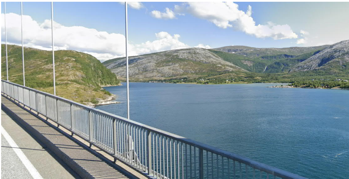
Figur 25 Fylkesvei 17 over Kjellingsundet. Området ligger innenfor landskapstype relativt åpent fjordlandskap med bebyggelse/infrastruktur . Omsøkt alternativ 1 vil krysse Beiarfjorden noe lenger inne i fjorden og over til Kjelling transformatorstasjon. Området er i landskapskartlegging i Nordland vurdert som god og typisk utforming og sjelden i regional sammenheng. Kilde: Google maps.
