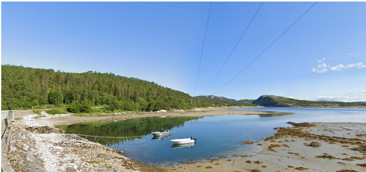
Figur 20 Fjordlandskap ved Trongsmauet, sør for Valnes. Bildet er tatt fra Valnesveien. Eksisterende 132 kV kraftledning går i dag over område. Ny omsøkt trasé vil krysse lenger sør utenfor bilde. Området ligger innenfor landskapstype relativt åpent fjordlandskap med bebyggelse/infrastruktur og har en sjelden utforming i regional sammenheng iht. Landskapskartlegging i Nordland. Kilde: Google maps.
