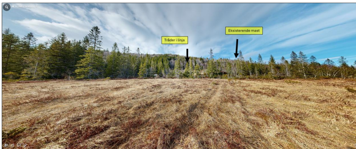
Figur 46 Skjermdump fra skannepunkt 2. Dette viser terrenget i perspektiv fra reinsdyrets øyehøyde. Trær, busker og fjell i bakgrunnen kamuflerer linja så mye at den nesten ikke er synlig fra nedforliggende myr. Trekkleia er her parallell med linja, men bildet er tatt opp 90 grader mot linja
