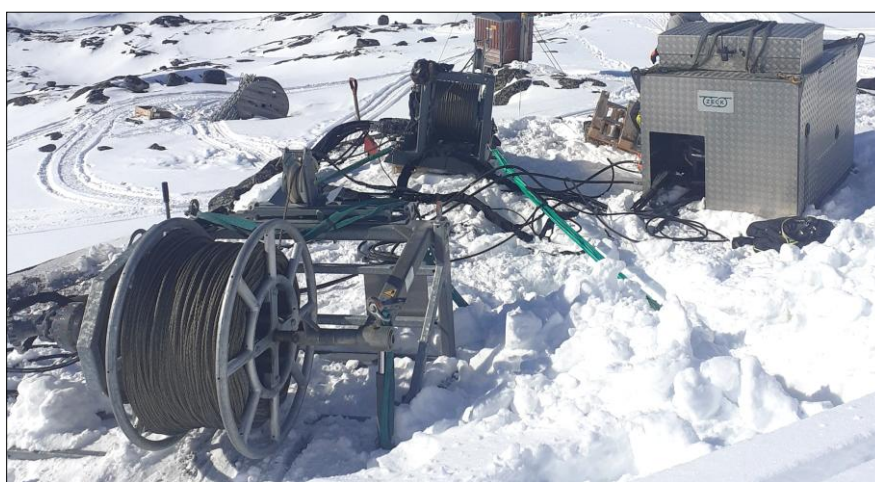
Figur 164 Eksempel på utstyr som benyttes ved strekking av linje. Bilde: Br Hals AS
