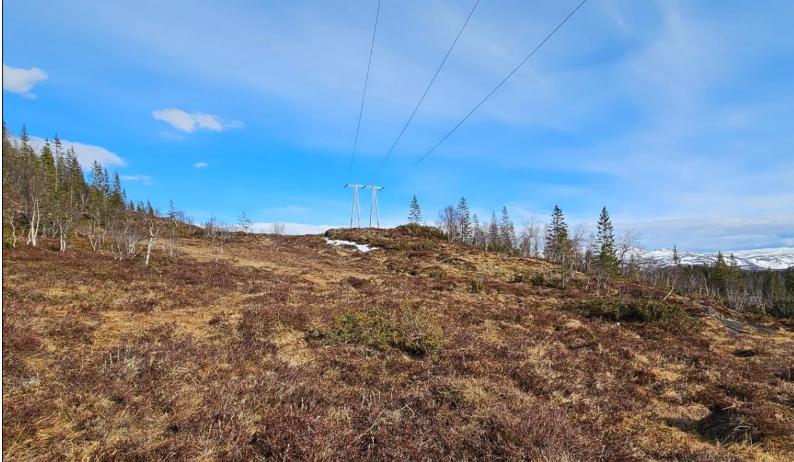
Figur 24 Eksisterende vinkelmast står på en høyde like ved 4. Rikmyr
