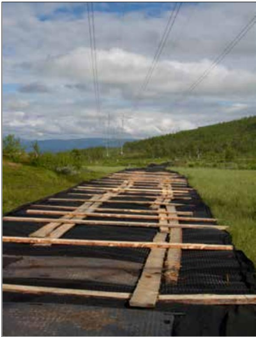
Figur 7: Ved å legge ut matter og planker i kjøretraséen kan terrengskader minimeres.
