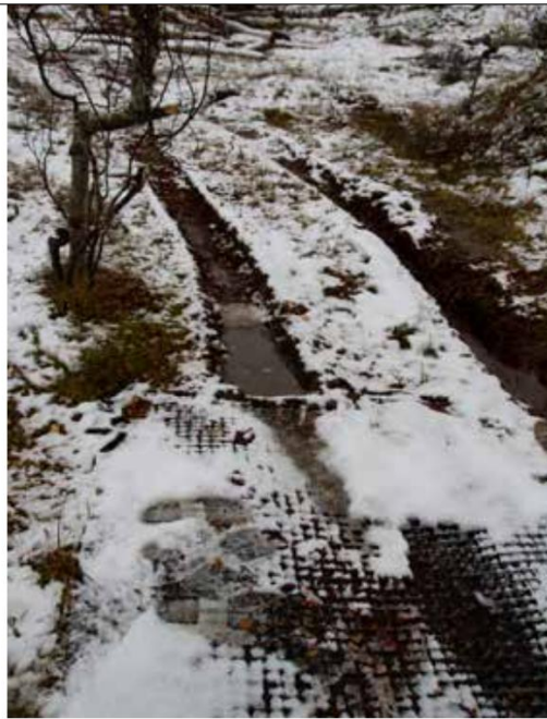
Figur 8: Geonett kan legges ut i våte områder for å minimere kjøreskader.
