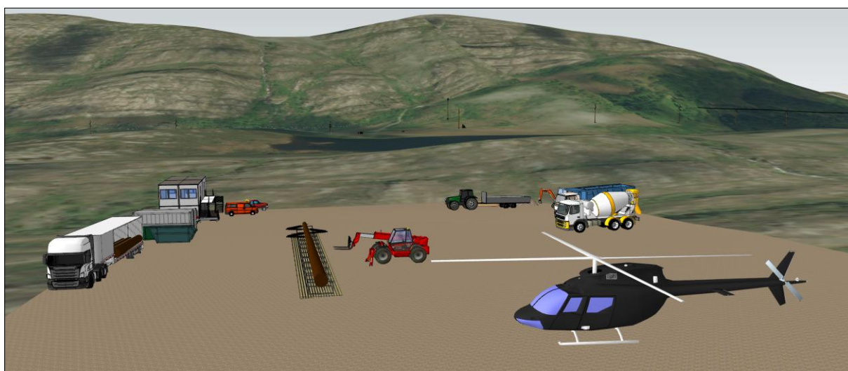
Figur 153 Primær landingsplass for helikopter blir ved de identifiserte riggområdene. Komposittmastene prefabrikkeres på riggområdene og flys ut. Visualisering: Torsjon AS.
