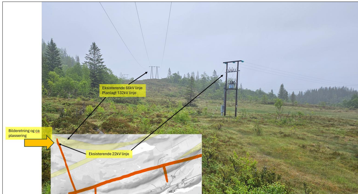
Figur 54 Bildet viser eksisterende 66kV linje, og en 22kV linje. Disse er plassert midt i trekk og flyttleia. Linea kan ikke se at planlagt løsning i nevneverdig grad vil medføre endringer mtp barriere og ledevirkning. 22kV linjen vil ikke bli berørt av dette prosjektet, og vil bestå slik den er i dag.
