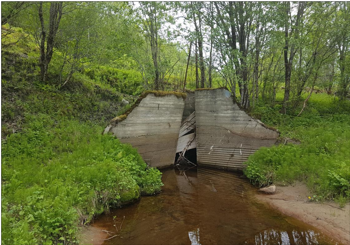
Figur 128 Betongkonstruksjon ved veien nede ved vannet. Foto: Torsjon AS
