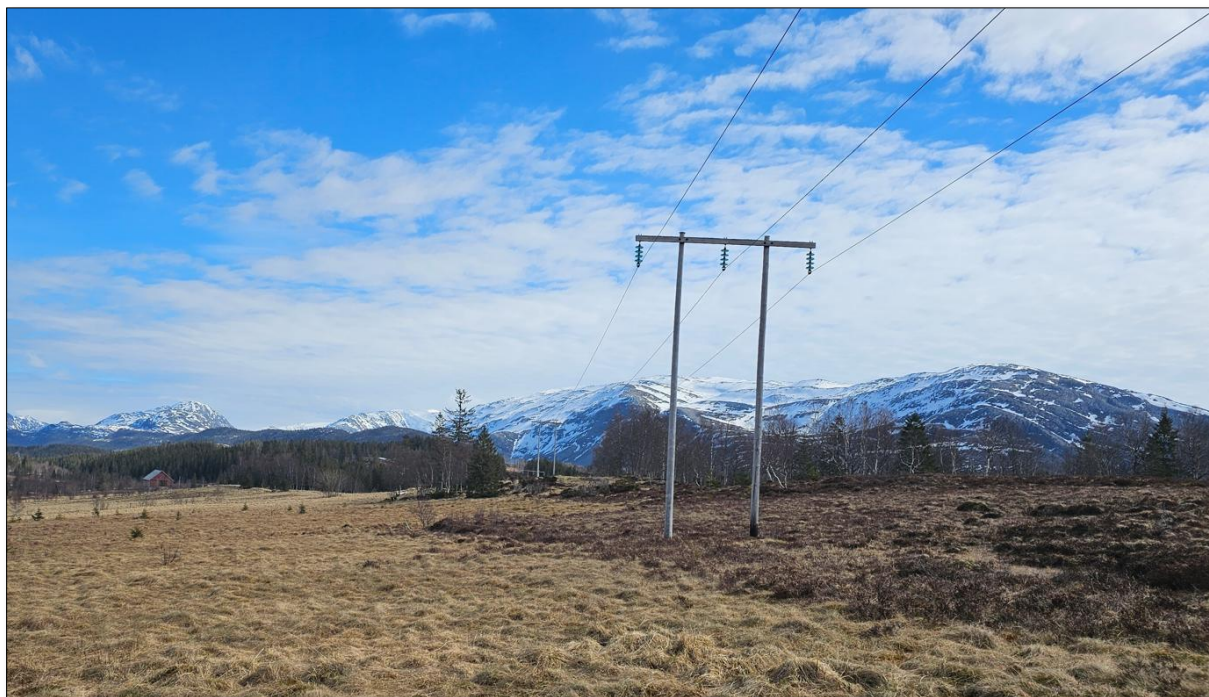
Figur 50 Bilde av eksisterende linje i nærheten av skannepunkt 3, ved Steffåsen. Her vises både silhuett og hvordan linjen forsvinner inn i bakgrunnen pga fjellene i bakgrunnen.
