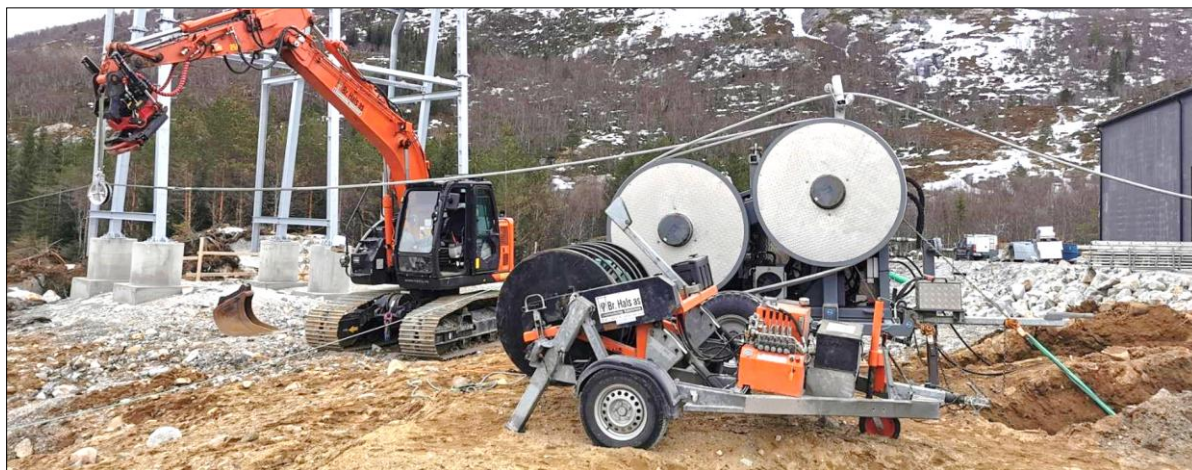
Figur 163 Eksempel på utstyr som benyttes ved strekking av linje. Bilde: Br Hals AS
