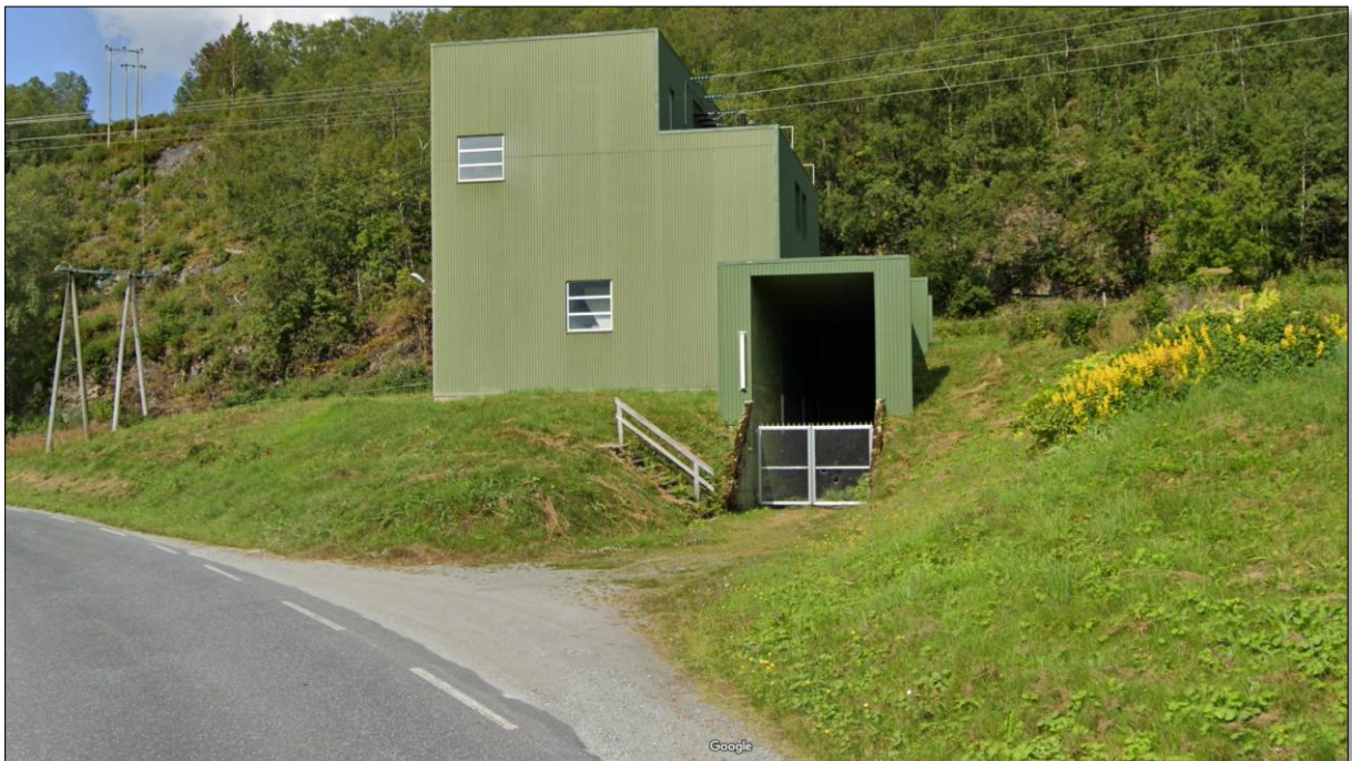
Figur 222 Bilder fra google streetview av eksisterende Meisfjord Transformatorstasjon. Denne skal nedlegges og rives dersom den ikke kan ombrukes.
