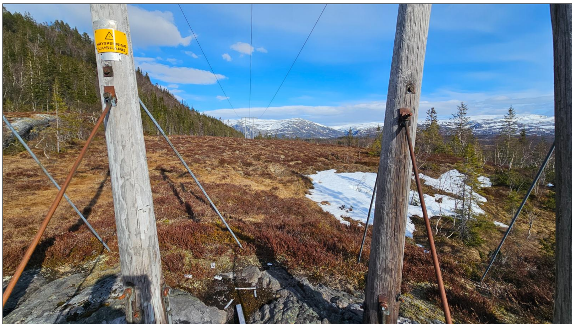
Figur 25 Detaljbilde av vinkelmasten. Den står på synlig berg.
