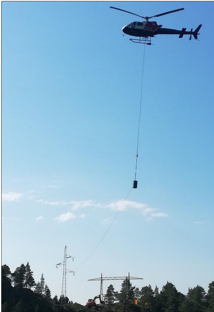
Figur 165 Eksempel på utstyr som benyttes ved strekking av linje. Bilde: Br Hals AS
