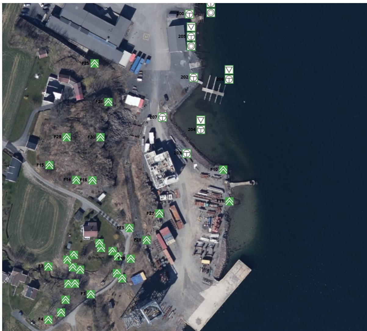
Figur 2: Kartlagt fjell i dagen - registrert på befaring 24.09.2024 og 10.12.2024
