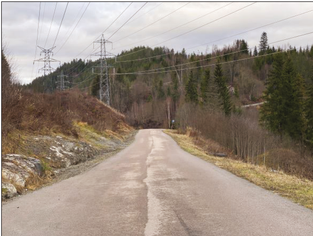
Figur 23 Kaggefossveien sett fra sør mot. Åsen hvor nytt koblings- og transformatoranlegg er omsøkt ligger midt i bildet. Eksisterende 50 kV og 132 kV kraftledning er synlig i bildet.
