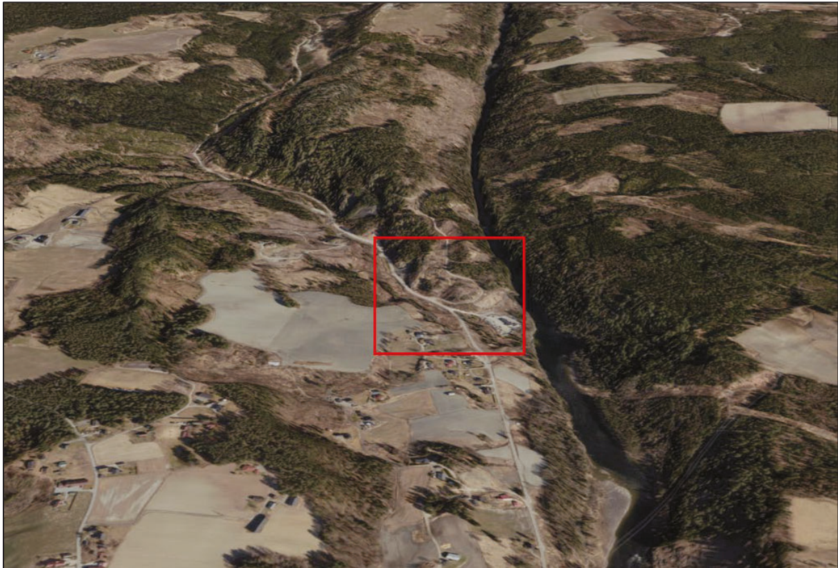
Figur 22 Oversikt over tiltaksområdet ved Kaggefoss kraftverk i Modum kommune. Rødt rektangel viser tiltaksområdet. Kilde: Geodata 3D-modell over Norge.
