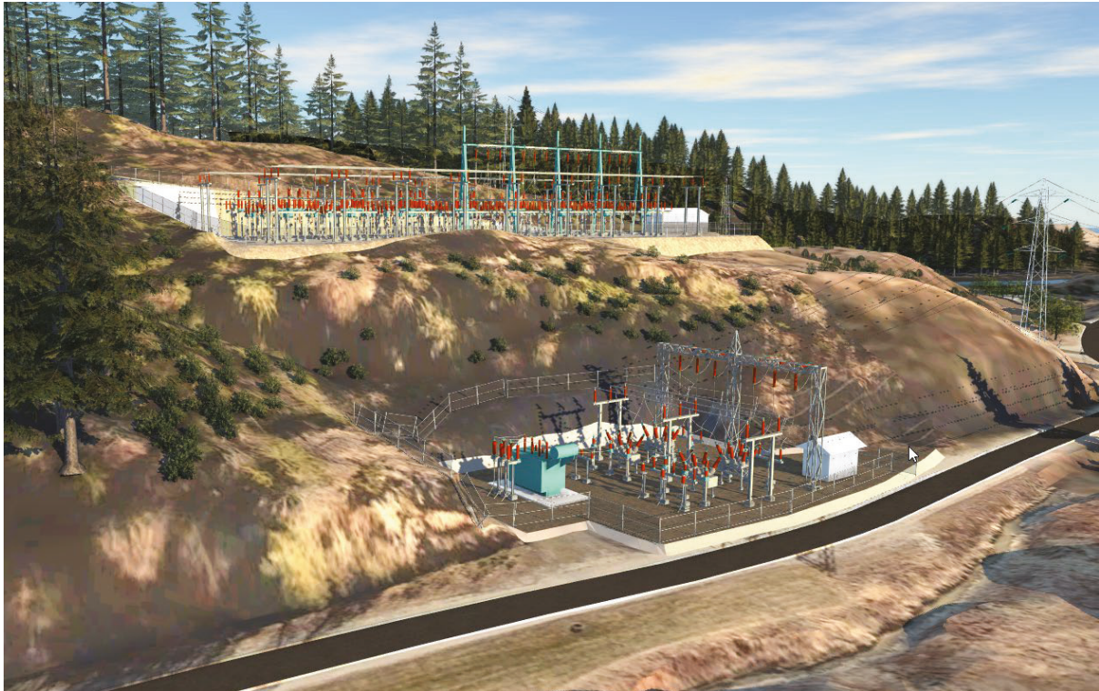
Figur 32 Modell av anlegget sett fra motsatt side av Mastedalen. Eksisterende Kaggefoss transformatorstasjon ses i forgrunnen. Modellen er ikke representativ med hensyn til vegetasjon som er tettere i virkeligheten.
