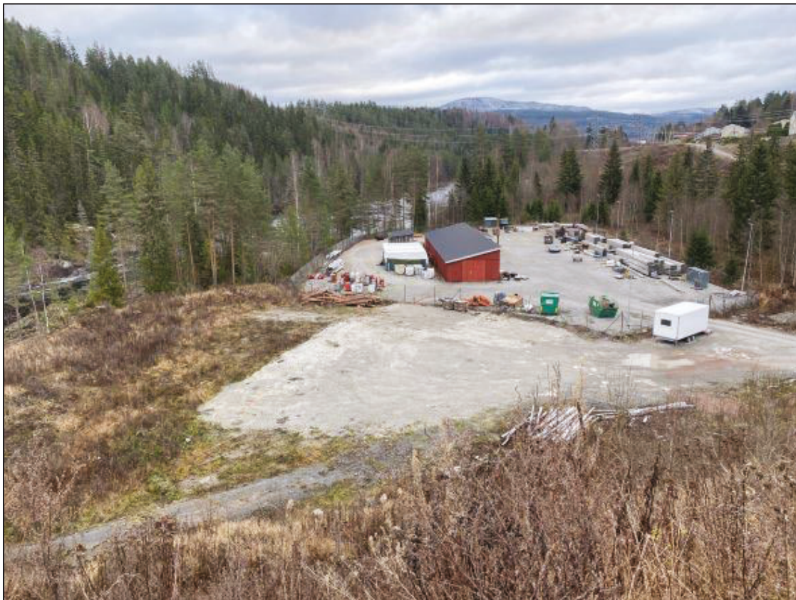
Figur 35 Eksisterende anleggsområde/lagerområde. Ny 132 kV kraftledning vil krysse området.
