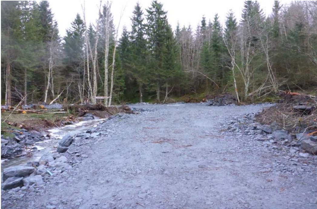
Figur 14: Hofstadelva etter utkjøring av steinmasser. Midlertidig løp ved siden av anleggsveien.
