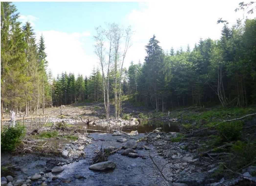
Figur 15: Samme sted som bildet over etter endt sikringsarbeid
