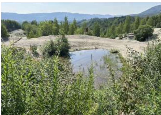
Dammen ved befarung i juni 2023 (sett mot sørvest). Det er ingen bekker som renner mot sør og sørvest fra dammen.
