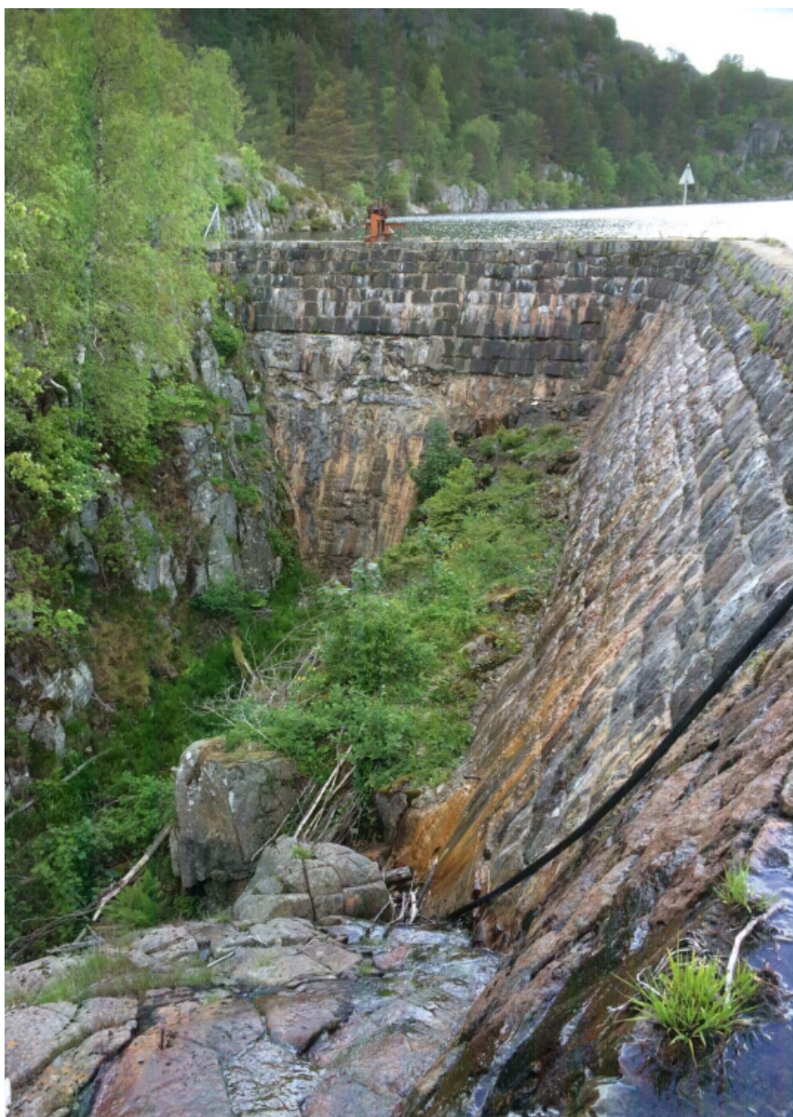
Figur 2 Dam Beiske med overløp i forkant av bildet og utsprengt bunnløp i midten. Det er planlagt å fjerne steinene i dammen. Støpt del av dammen i utsprengt løp er planlagt satt igjen for å beholde vannspeilet slik det var før oppdemmingen.
