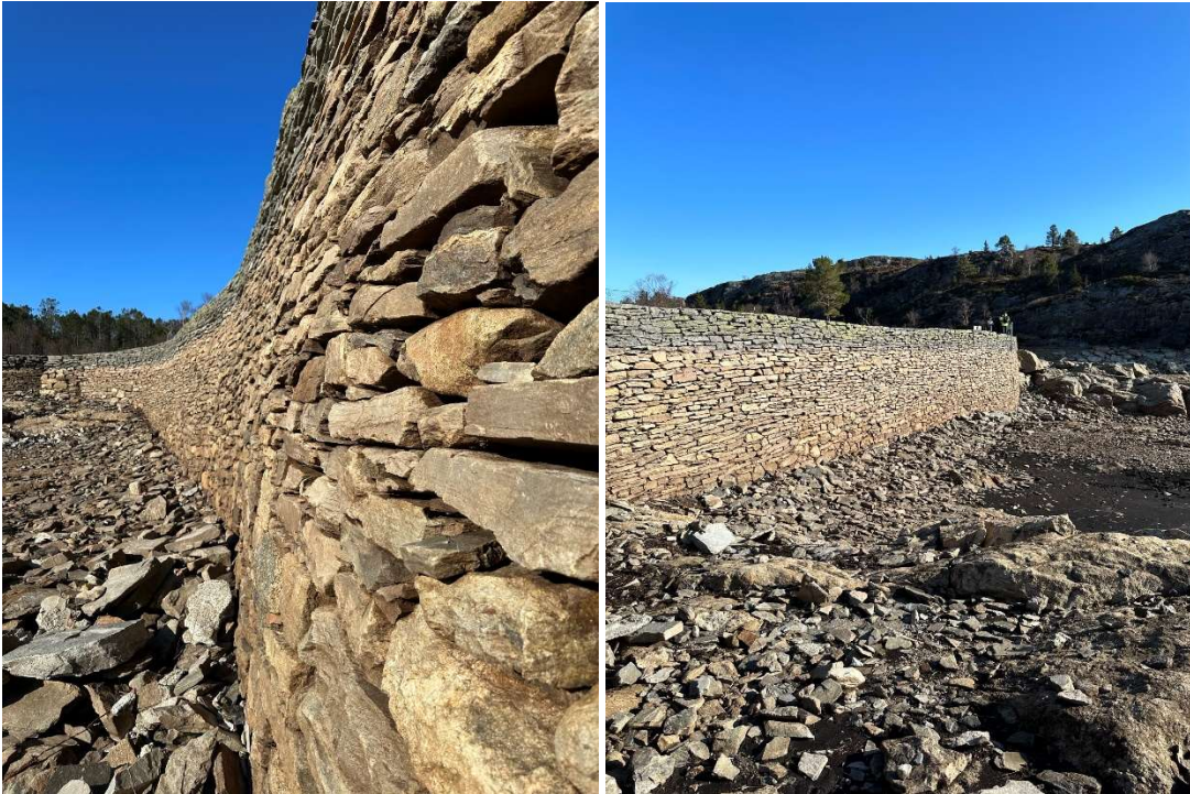
Figur 3: Bilde mur 1, innside dam.
