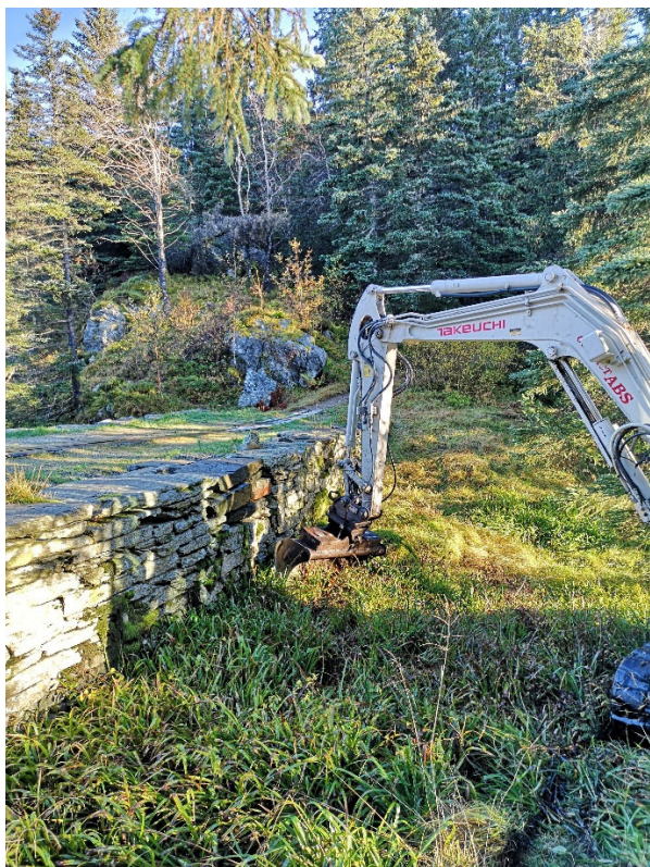
Bilde 1. PG1. Oppstart graving.
