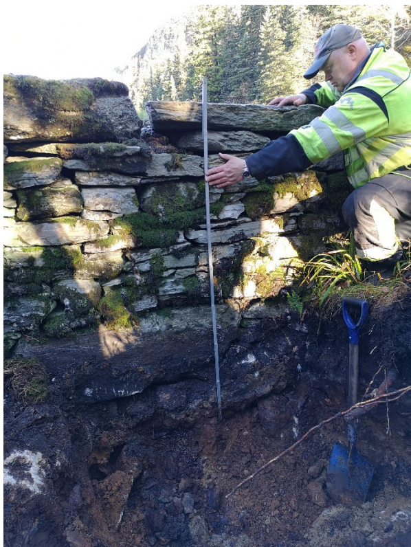
Bilde 11. PG3. Mål høyde nedstrøms mur.
