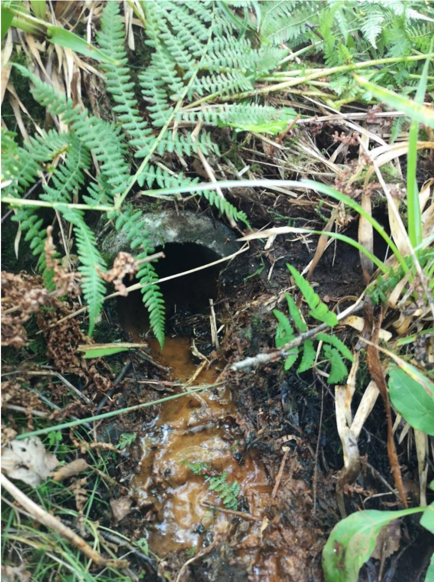
Figur 7 Betongrør (utløp i same området som utløpet til tapperør A). Antekte å fungere som drenerør fra ventilkum. Kjelde: Bergen kommune
