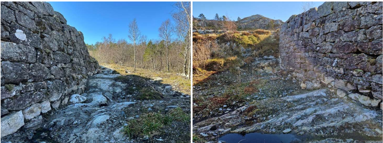
Figur 4: Bilde mur 1, utside dam.
