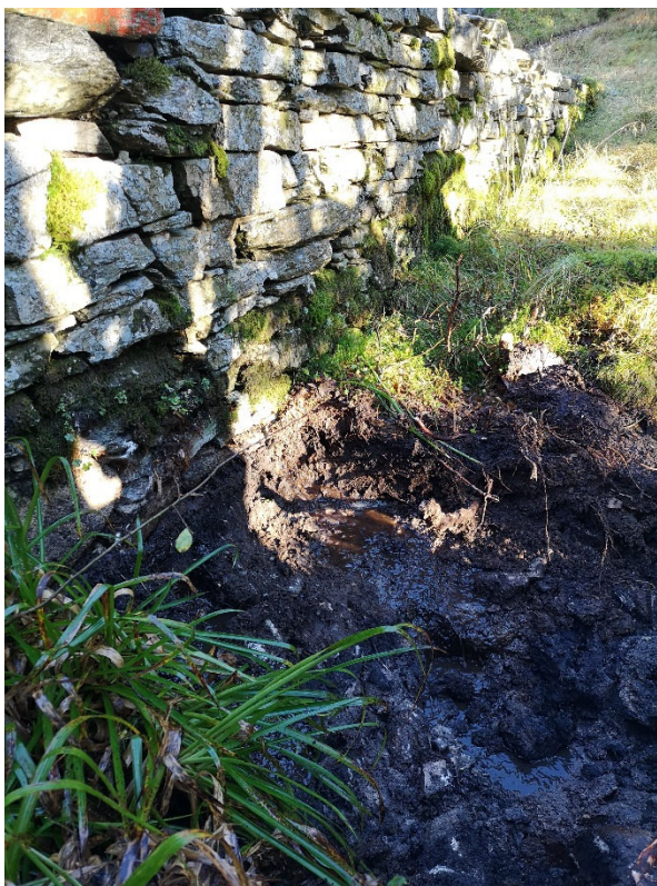
Bilde 2. PG1. Vann fra dam/magasin inn i prøvegrop.
