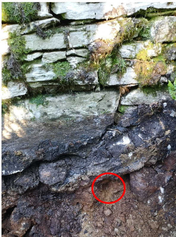
Bilde 12. PG3. Antatt morenemasser i fundament for mur. Lokasjon uttak av poseprøve vist med rød sirkel.
