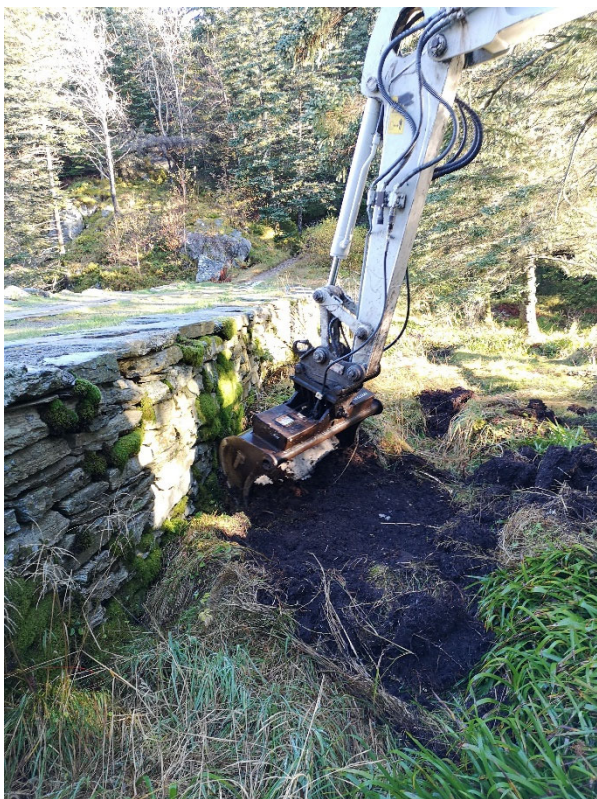
Bilde 5. PG2. Oppstart graving.
