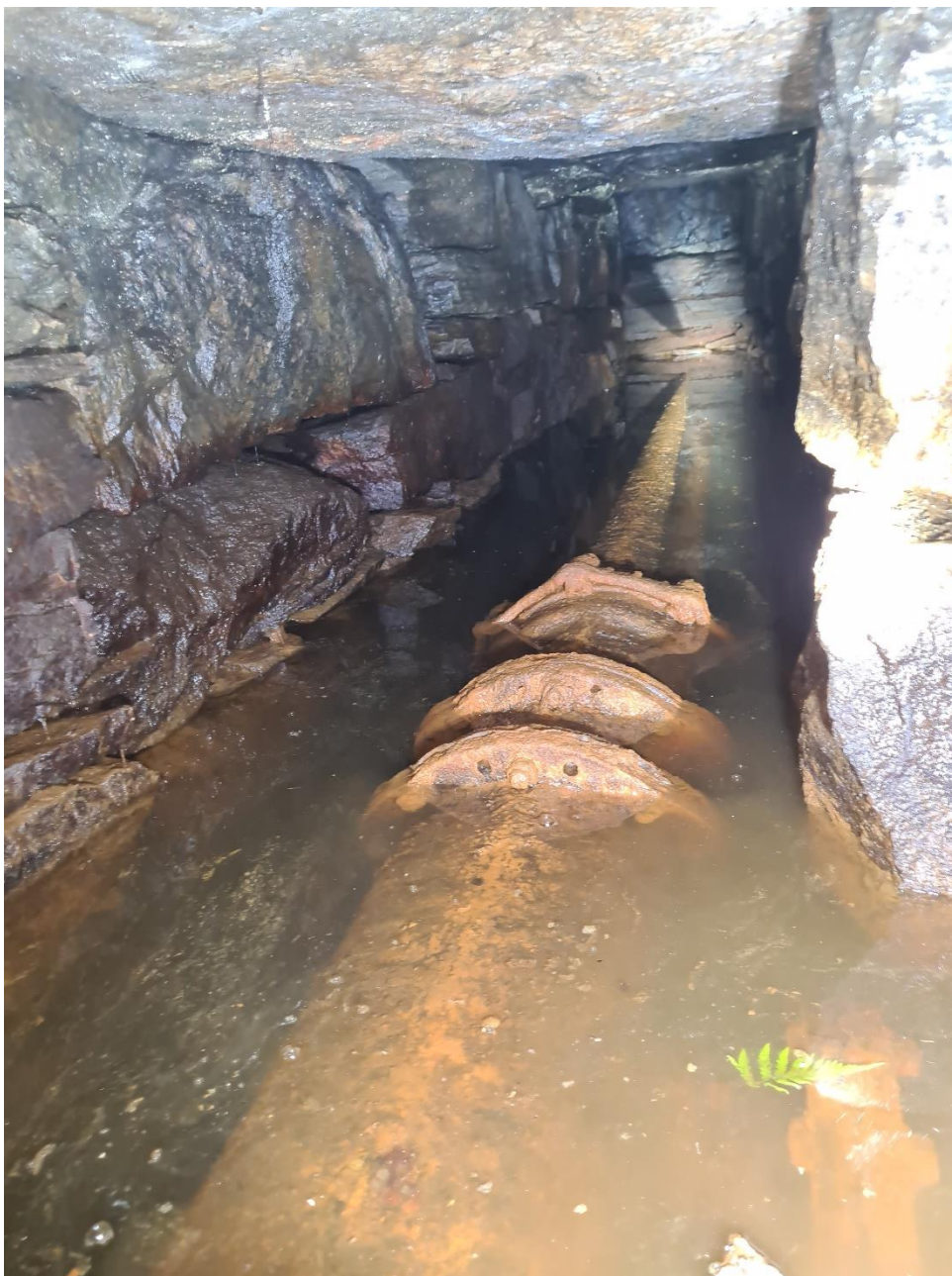
Figur 5 Tapperør igjennom dammen. Bilete er teken frå ventilkum på nedstraums side av dammen. Kjelde: Bergen kommune
