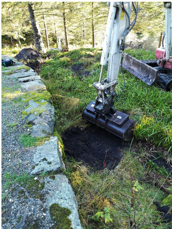
Bilde 9. PG3. Oppstart graving.
