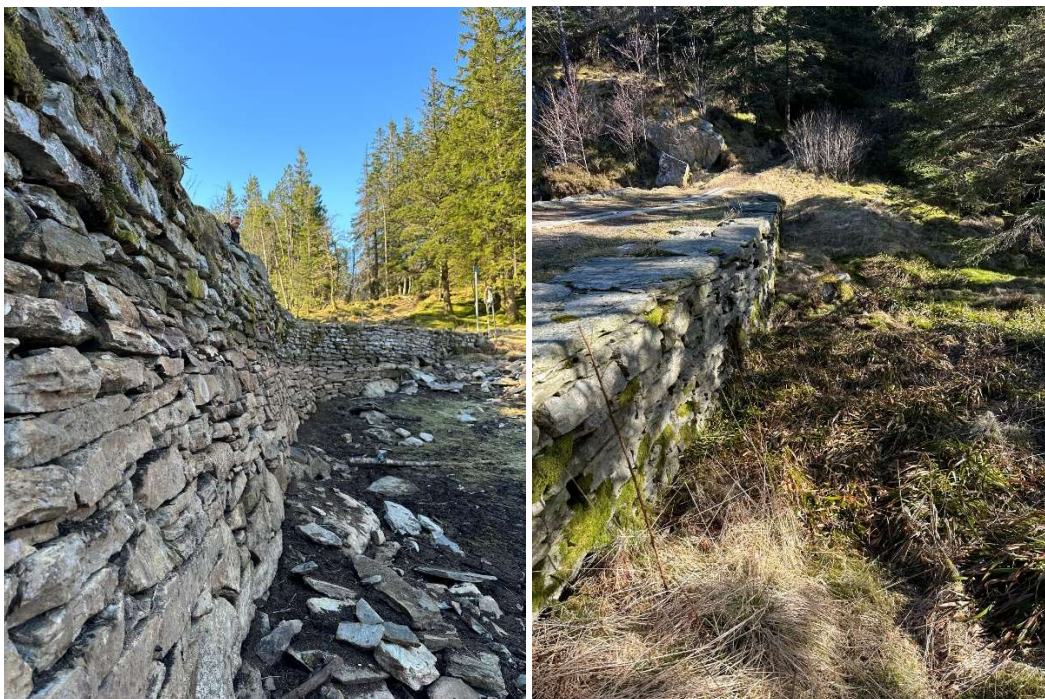
Figur 8: Bilder av dam/mur 3.
