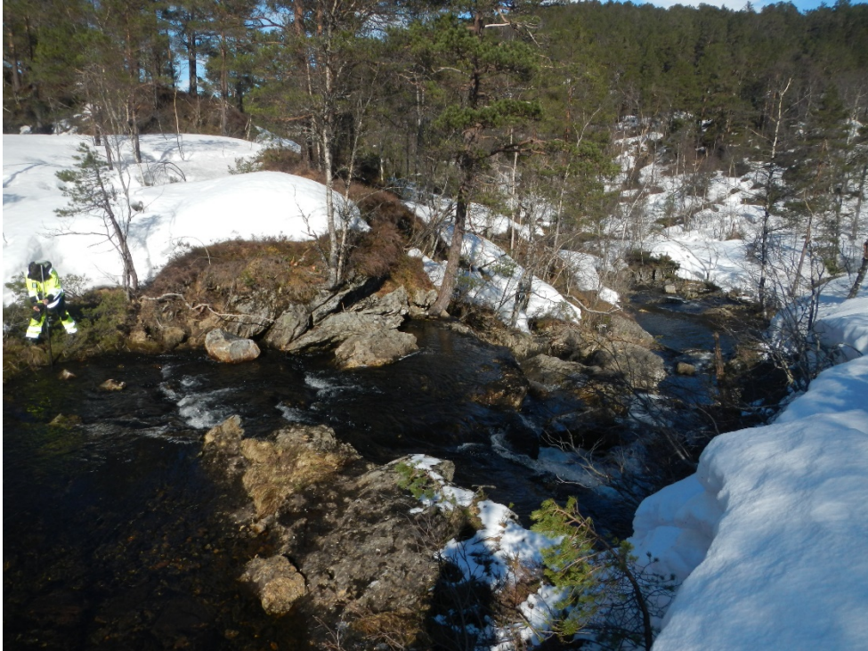
Bilde 5 Ved inntaksområde
