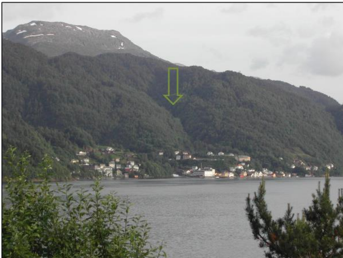
Figur 11. Smådalselva drenerer mot nord og ligger nedsenket i terrenget, godt skjermet av skog. Bebyggelse og jordbruksareal er konsentrert nede ved fjorden. Planlagt kraftstasjon er plassert i overkant/bakkant av bebyggelsen sentralt på bildet. Høyeste punkt, Burlifjellet (854 moh.), sees i bakgrunnen.
