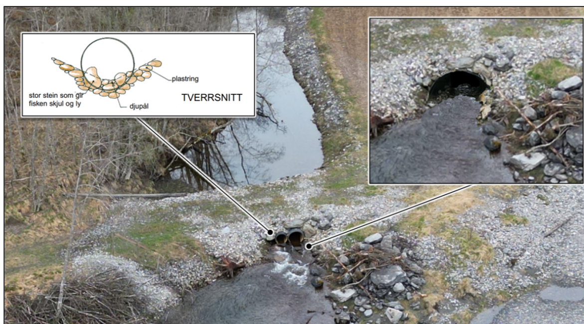
Figur 6-6: Stikkrennen like ved Øvelandsgrovns utløp i Fortunselvi burde utbedres. Dagens gjennomløp kan utgjøre en flaskehals for yngel og ungfisk. For at habitattiltak i Øvelandsgrovi skal bli vellykket, må først denne stikkrennen utbedres slik at fisk kan vandre fritt. Større dimensjon på gjennomløpet (Ø600mm - 1000mm) vil også forbedre flomsituasjonen - prinsippsskisse for utforming av gjennomløp og mulig fremtidig utseende er presentert i figuren. Dronefoto: Hydro Energi AS
