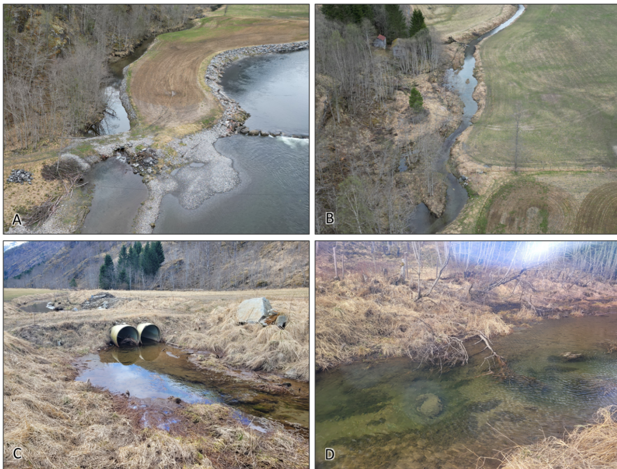
Figur 6-3: Øvelandsgrovi i mai 2023. Dronefoto: Hydro Energi AS. A) Utløpet i Fortunselvi er delvis sperret av en fylling med to mindre rør. B) Oversiktsbilde. C) To rør oppstrøms i et svært stilleflytende parti. D) Rotvelt og variasjon i bunnforhold.
