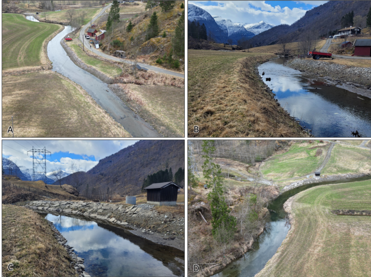
Figur 6-2: Haugelvi i mai 2023, dronebilder er tatt av Hydro Energi AS. A) Homogen strømning, lite skjul og kantvegetasjon. Erosjonssår etter 2018-flommen er utbedret og breddene er glattet ut. B) Gresskledd kant, stilleflytende vann med lite variasjon i strømning. C) Yttersving ved Bjørkhaugen gjenoppbygd og plastret med store blokker etter at flommen tok nytt løp. Merk det svarte pumpehuset som referansepunkt. D) Strekningen nedstrøms pumpehuset har noe mer kantvegetasjon, variasjon i grunnforhold og skjul, men fremdeles relativt glatt og homogen.
