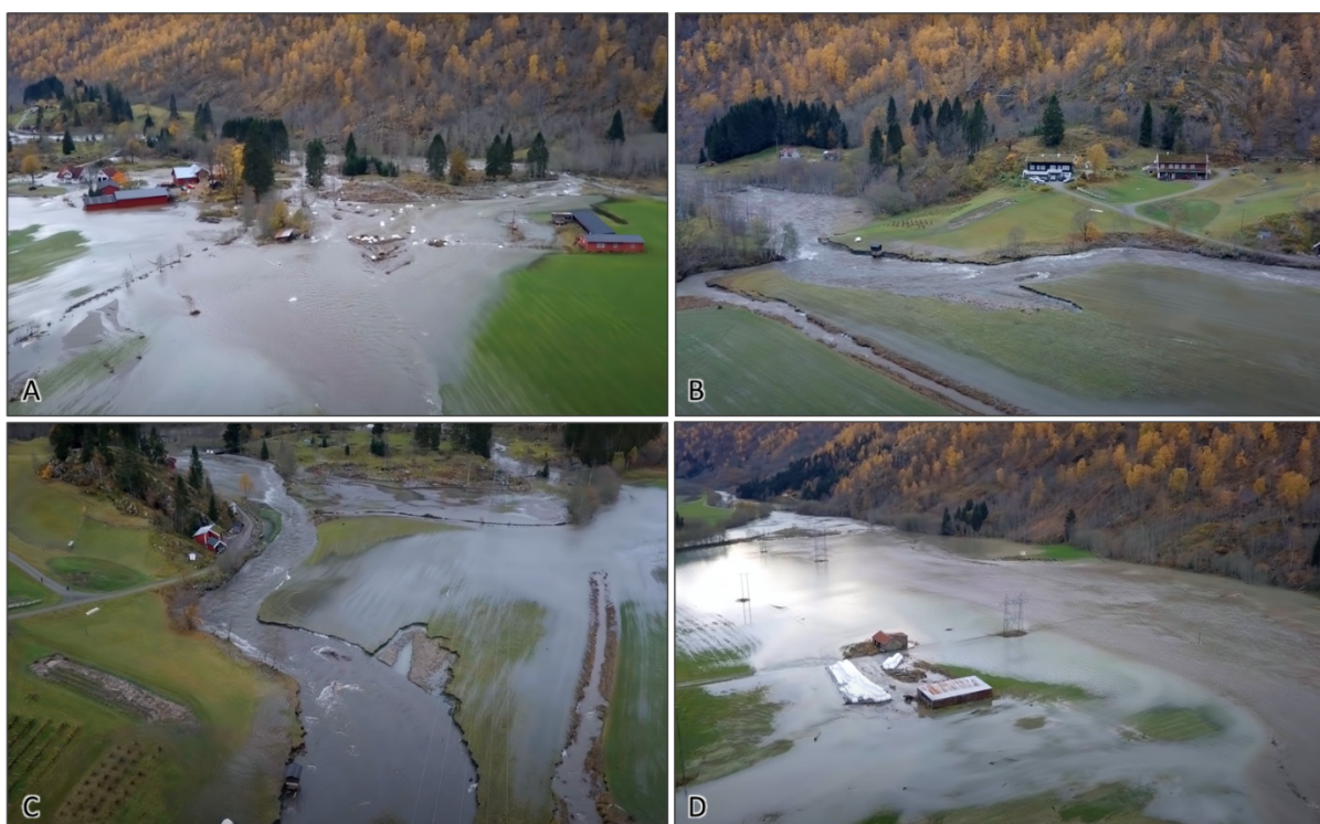
Figur 6-1: Oversvømmelse og erosjonsskader etter flommen i 2018. Skjermdump av dronevideo (filmet av Ole Gudmund Bjørk) fra rett etter flommen, 15.10.18. A) Bjørk går, oversvømt og mye skade på dyrkamark. B) Haugelvi har erodert kraftig i yttersving og tatt et nytt flomløp ved Bjørkahaugen. C) Haugelvi går flomstor og har erodert kraftig på dyrkamark. D) Øvelandsgrovi og tilstøtende landbruksareal er kraftig oversvømt.
