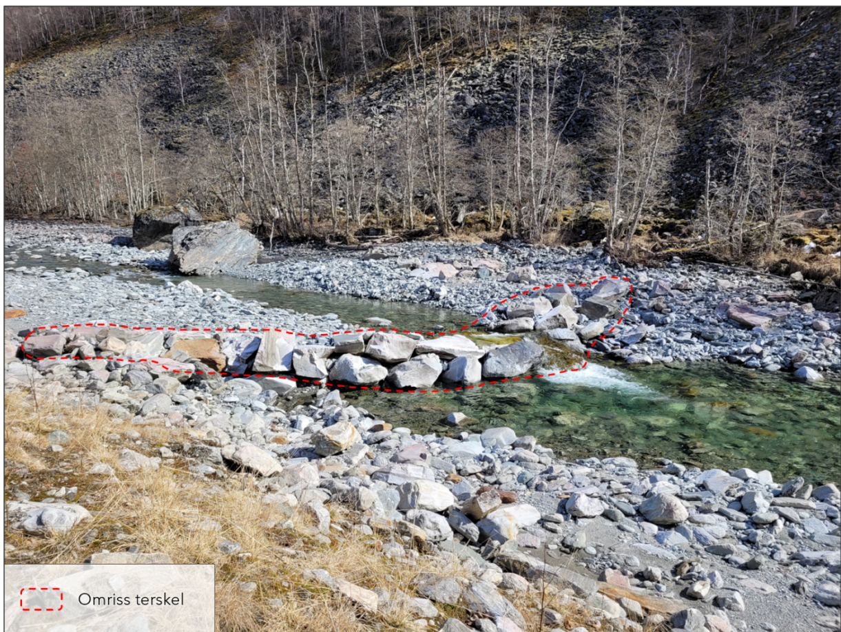
Figur 4-9: Terskel ved Øyane Midtre er etablert etter 2019. Det har relativt raskt blitt avsatt masser oppstrøms, men det er blitt en liten kulp nedstrøms. Terskelen har en gunstig lavvannsrenne i midten.
