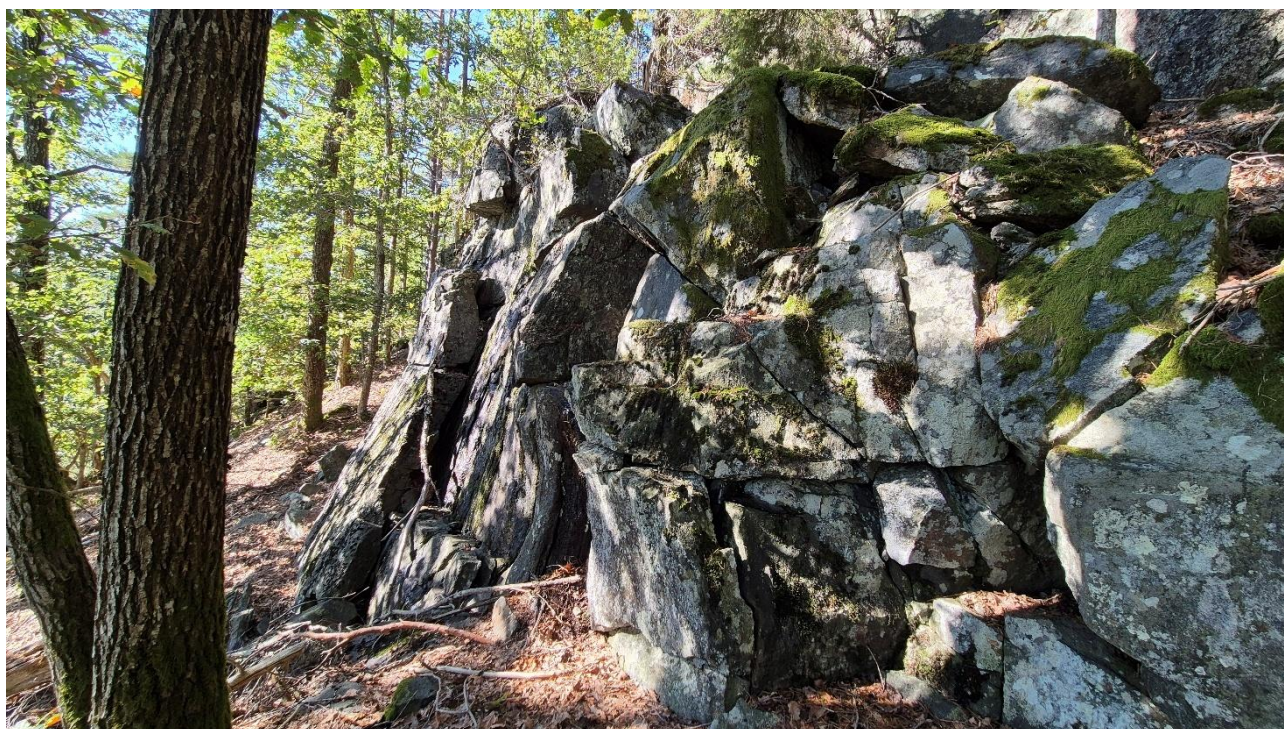
Figur 18: Bergblotning med gjennomgående sprekesett. Spor etter nylig utfall ved foten. Løsningsannsynlighet vurderes å være større enn 1/100. Foto fra infopunkt 10.
