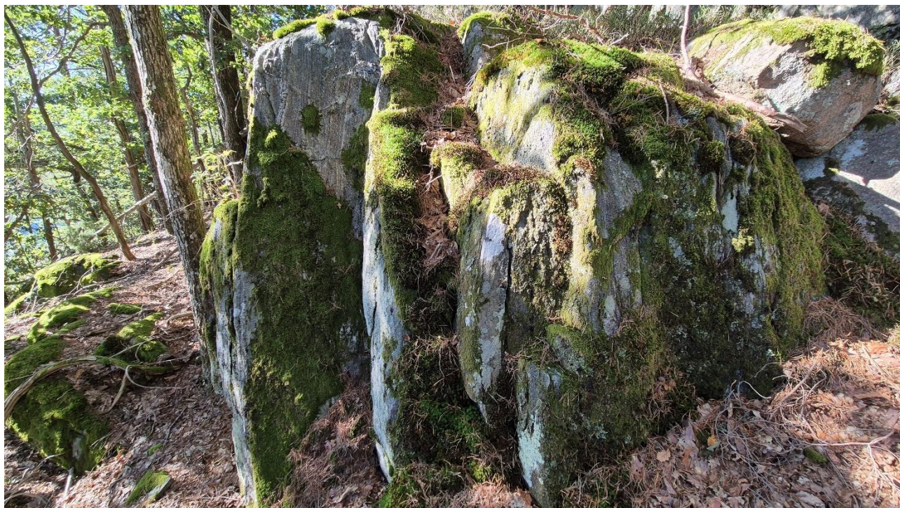
Figur 17: Opprekkning langs steil foliasjon. Potensial for flakdannelse. Løsningsannsynlighet vurderes å være større enn 1/1000, men mindre enn 1/100. Spor etter steinsprangavsetning under skrenten. Foto fra infopunkt 10.
